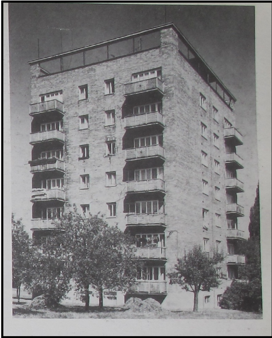
5 Bodový osmipatrový bytový dům.
