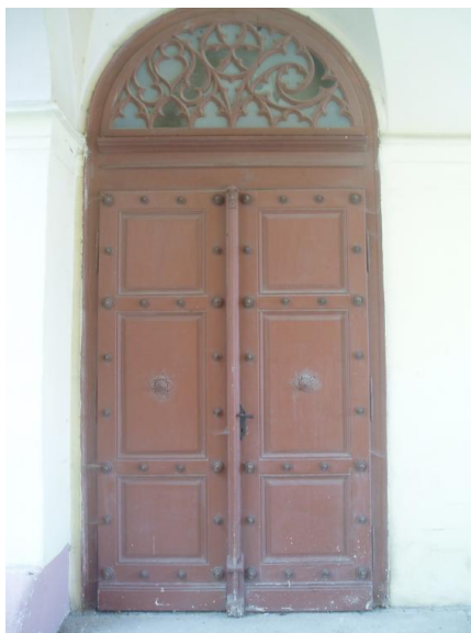
Obr. 4e Zdobené dveře trhanovského zámku.
