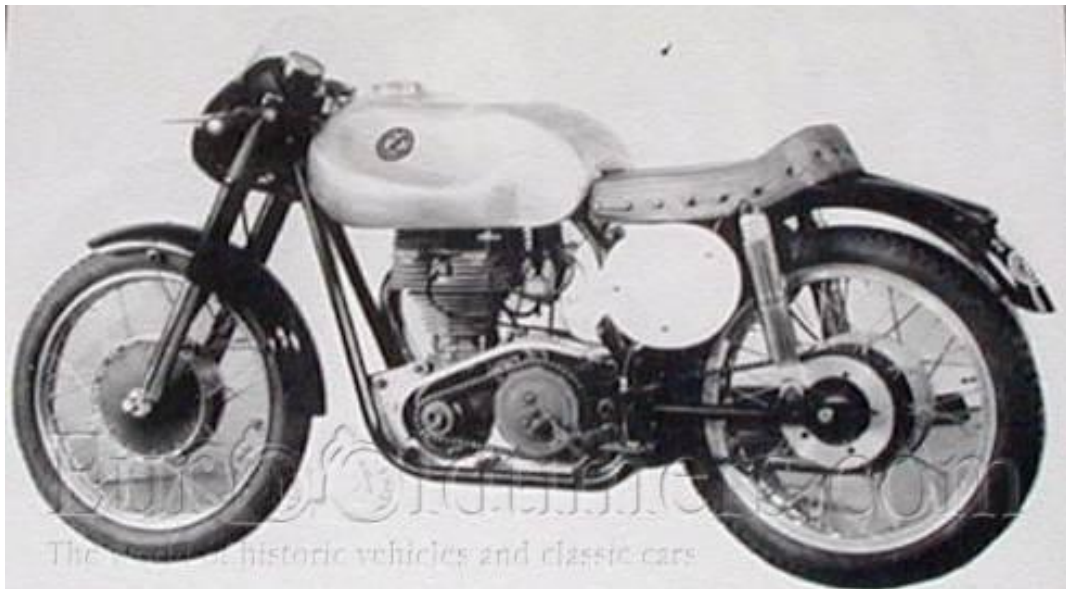
9) ČZ typ 851 – 350 ccm Motocykl s motorem konstruovaný J. Walterem. 146
