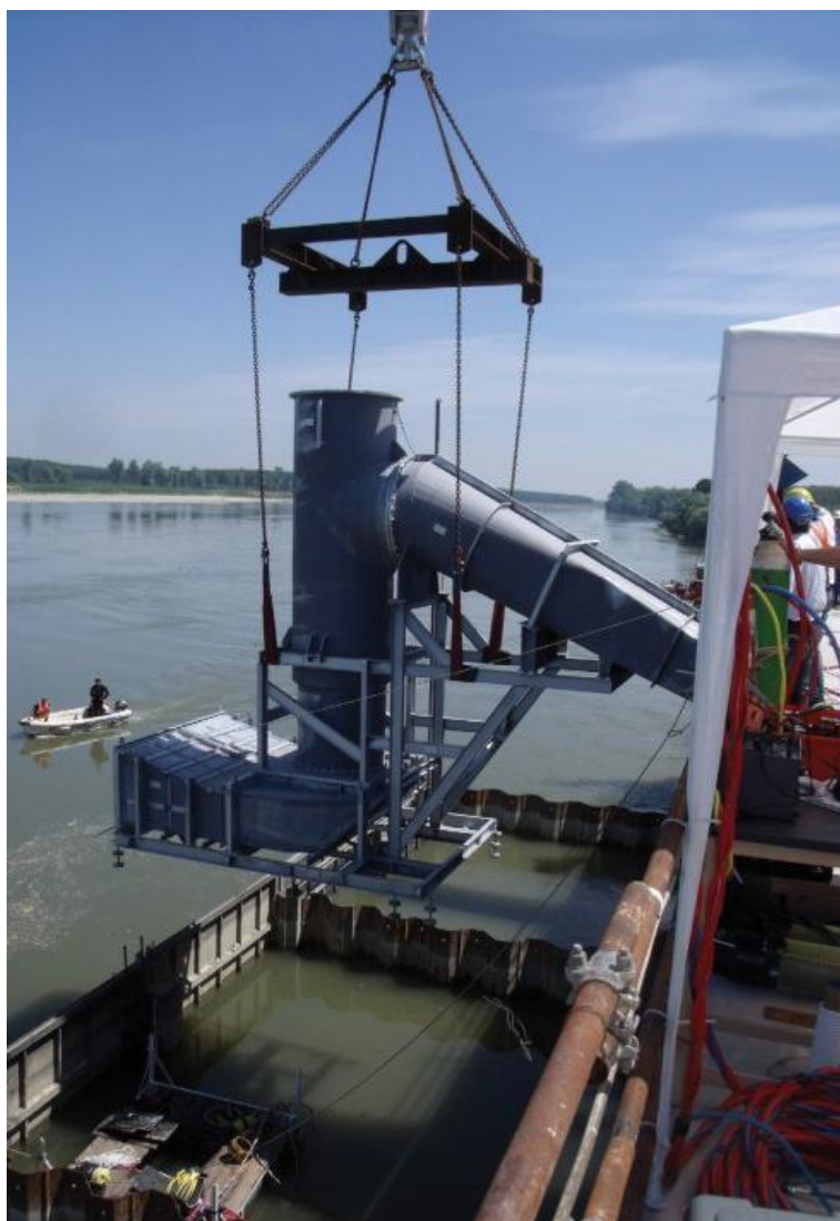
Obr. 4.1.1.2.1: Montáž 15 t posilovacího čerpadla na řece Pád [8]
