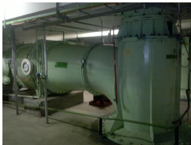
Obr. 2.2.2: Armatura na výtlaku ch. č.
