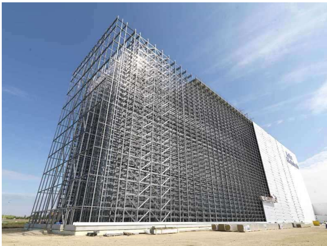
Obrázek 2-10 Automatizovaný paletový sklad [13]
