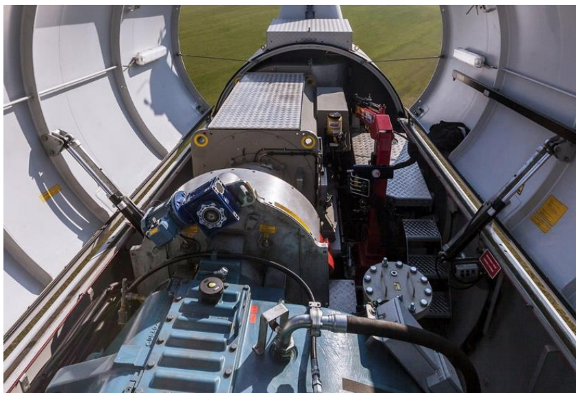
Obr. 7 Asynchronní generátor větrné elektrárny [16]
