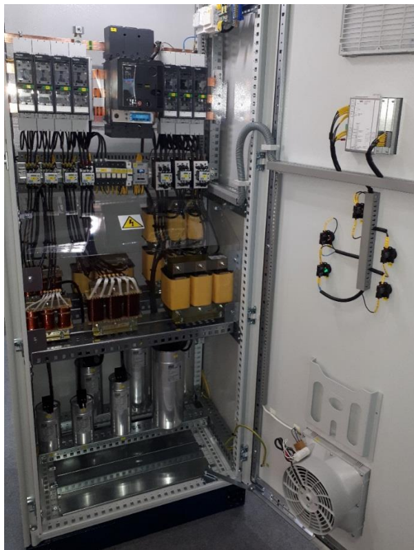
Obr. 35 Chráněný nn kompenzační rozvaděč ZEZ Silko
