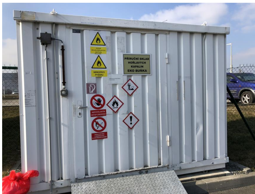
Obr. 6 Sklad hořlavých kapalin [Zdroj: vlastní]
