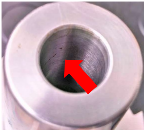
Obr. 6-7 Koroze funkční plochy, vzorek 1-E
