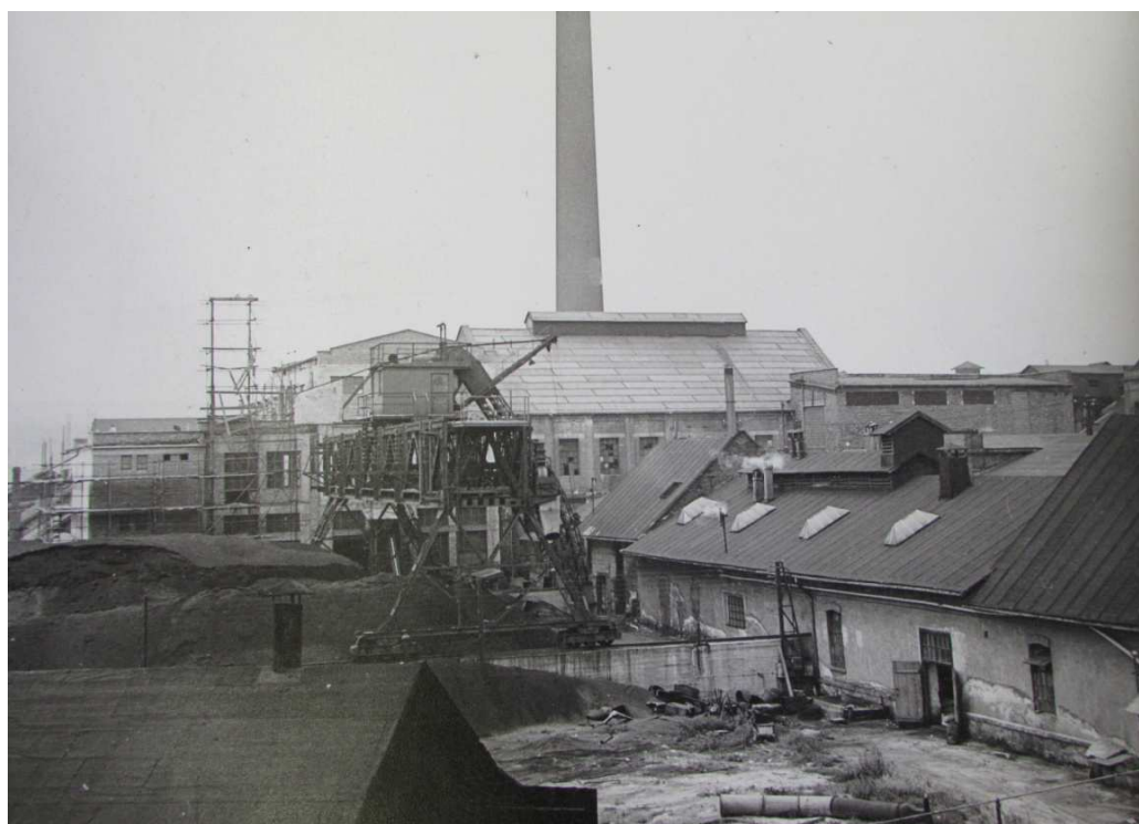
Obrázek 8: Budova kotelny a elektrocentrály v roce 1981
