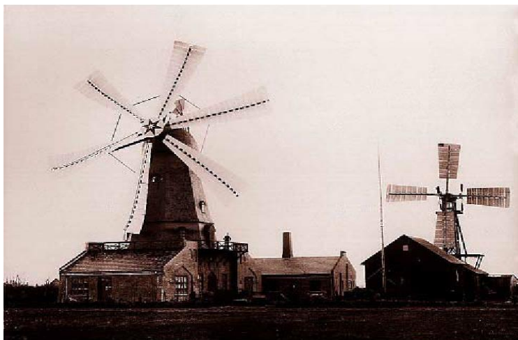
Obr. 3.10. První větrná elektrárna v Evropě – Askov, Dánsko
