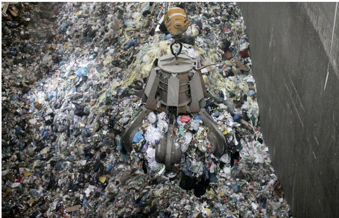
obr. č. 16: Homogenizace odpadu v bunkru
