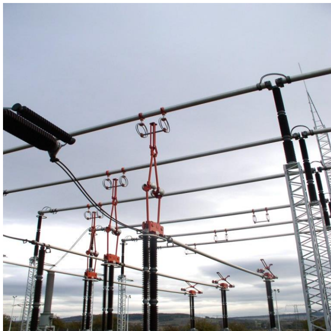
Obr. 2 Přípojnicové odpojovače zapnuté na přípojnice [Převzato z[8]]
