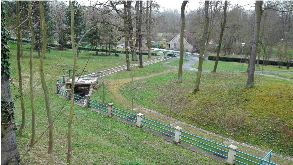
Obr. č. 5 - Prázdné koryto určené k odvodnění území a odlehčení kanalizace v Lochotínském parku
