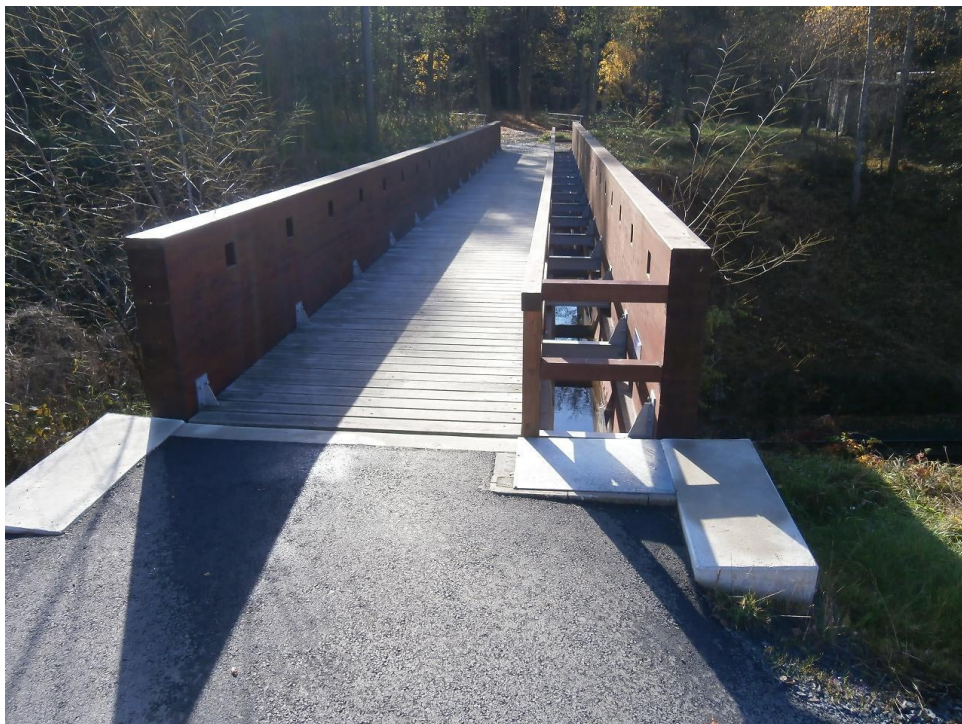
Obrázek č. 10: unikátně architektonicky řešený akvadukt u Havlovic
