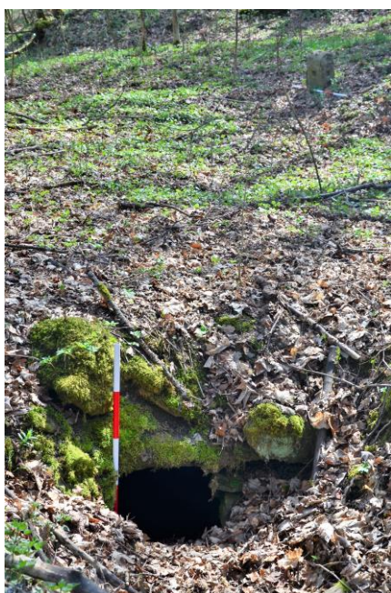
Obrázek 39: Vstup do sklepa č. parcelní 29. Pohled od severovýchodu. 14. 4. 2018.
