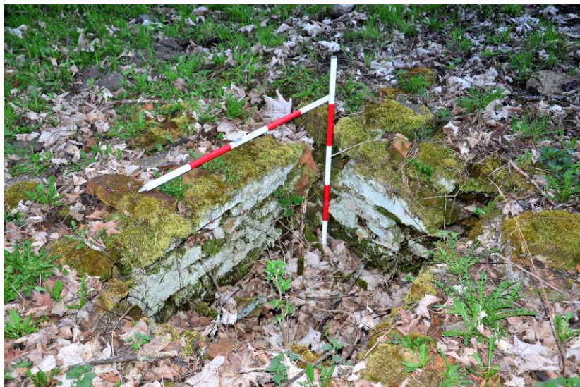
Obrázek 53: Cihlová stavba na místě domu čp. 39. Pohled od severovýchodu. 19. 4. 2018.
