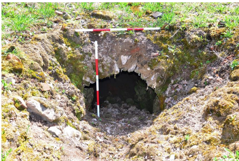
Obrázek 48: Vstup do sklepa pod budovou fary. Pohled od severu. 19. 4. 2018.
