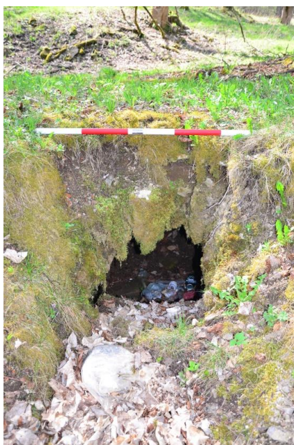
Obrázek 46: Zasypaný vstup do objektu na parcele č. 6. Pohled od východu. 19. 4. 2018.
