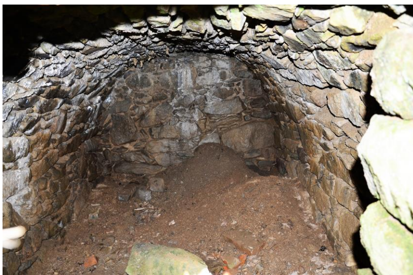
Obrázek 42: Vnitřek sklepa na parcele č. 29. 14. 4. 2018.
