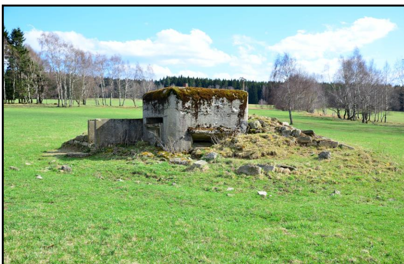
Obrázek 7: Jeden ze čtyř výcvikových bunkerů. 14. 4. 2018. Pohled od severovýchodu.
