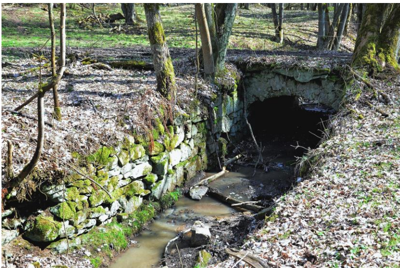
Obrázek 24: Kamenný mostek z doby existence obce. 14. 4. 2018. Pohled od severu.
