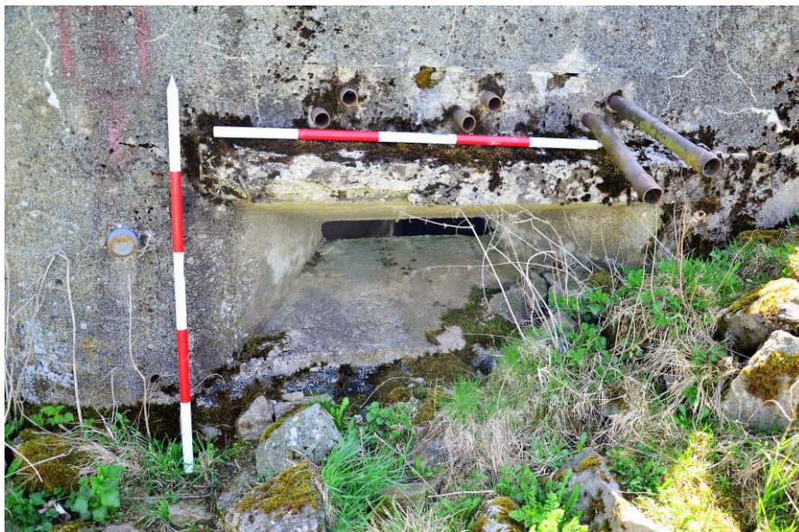
Obrázek 8: Železné trubky pro lana k pohybování s terčí. 14. 4. 2018.
