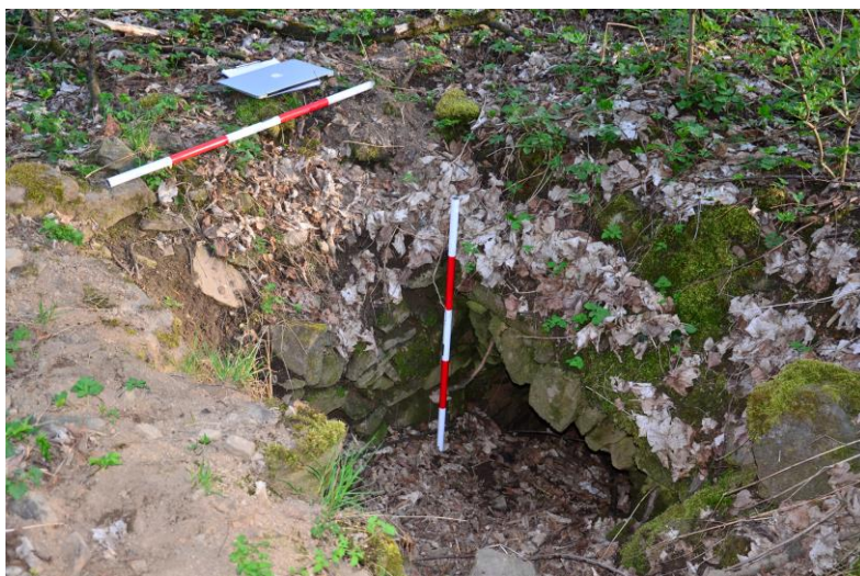
Obrázek 43: Vstup do sklepa na parcele č. 17. 14. 4. 2018.
