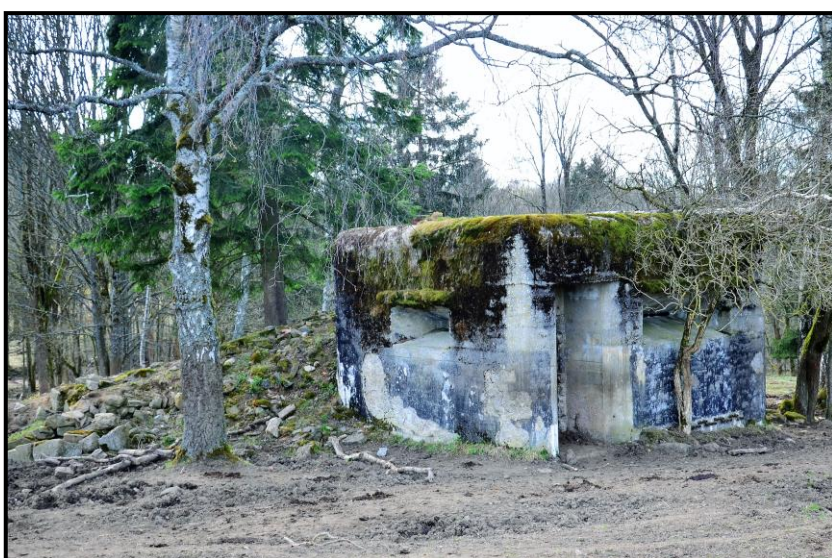
Obrázek 6: Velitelský bunkr (pozorovací stanice) VVT Prameny. Pohled od jihovýchodu. 14. 4. 2018.
