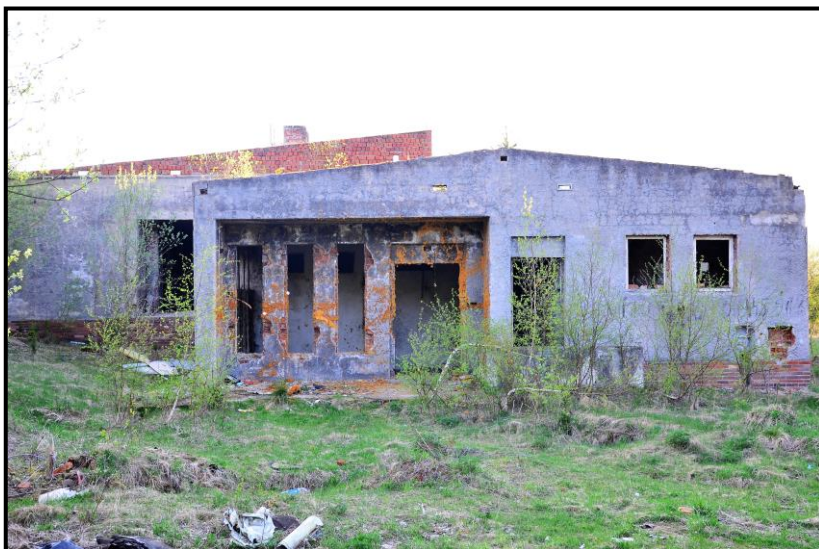
Obrázek 5: Kasárna 12. protiraketového pluku Mariánské Lázně – Klimentov.
