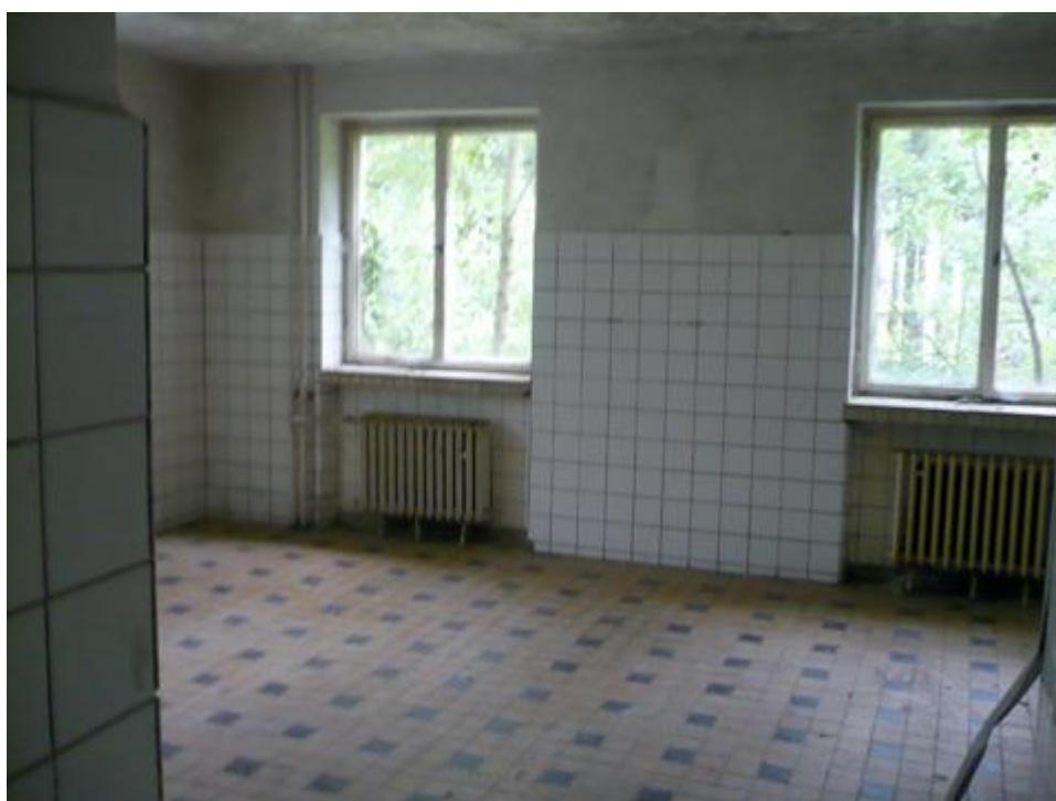
Obr. 22: Objekt hlavní budovy 1. roty pohraniční stráže Černé jezero (interiér)
