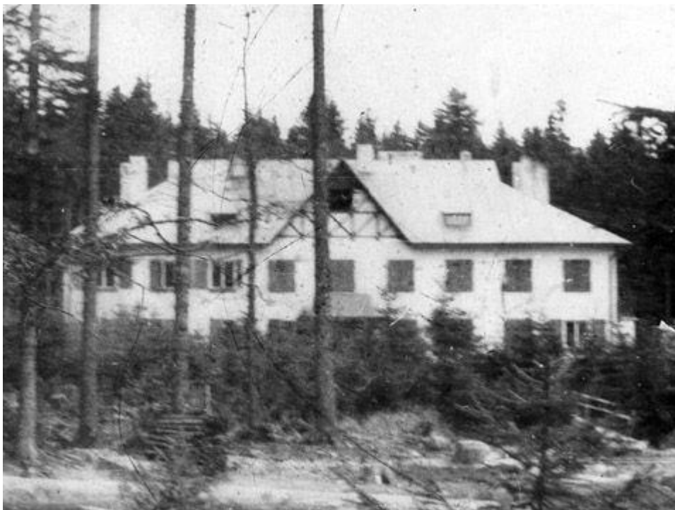
Obr. 19: Objekt hlavní budovy 1. roty pohraniční stráže Černé jezero z konce 50. let Foto: Šerfel J.: Tak vyzerala rota v roku 1959, pořizeno: 1958 – 60 [online], [cit. 2017-04-23], obrázek ve formátu JPG, dostupné z: http://www.vojensko.cz/cerne-jezero-r-1959
