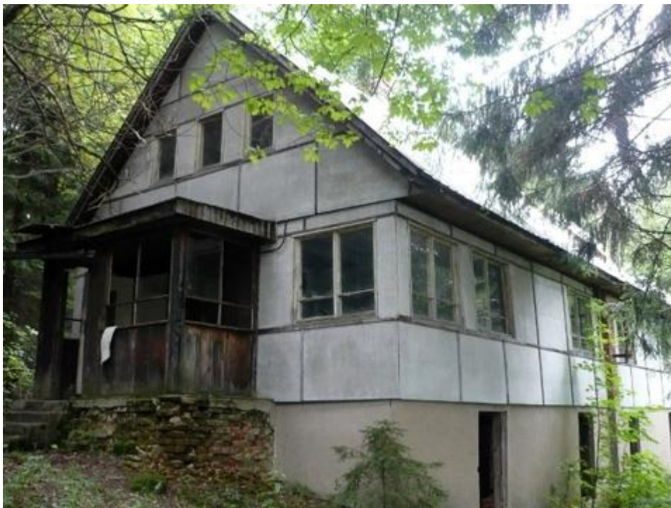
Obr. 11: Objekt zaniklého finského domku tzv. „fiňáku“
