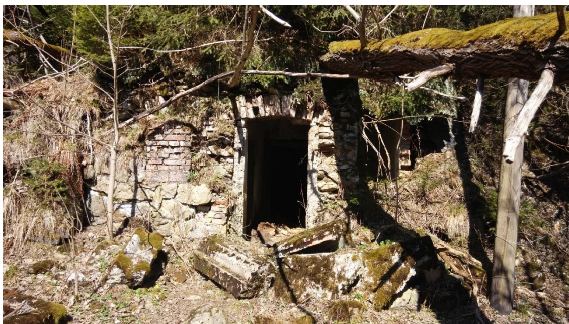
Obr. 32: Objekt sklípku při bývalé turistické chatě u Černého jezera
