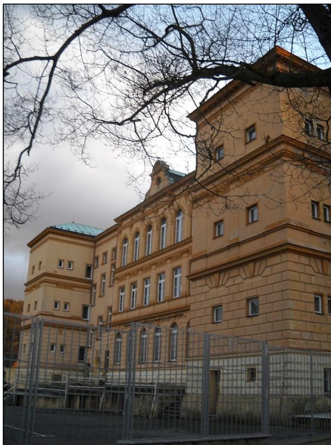
Fotografie č. 61 – Pohled na zadní část školy a školní dvůr. 126
