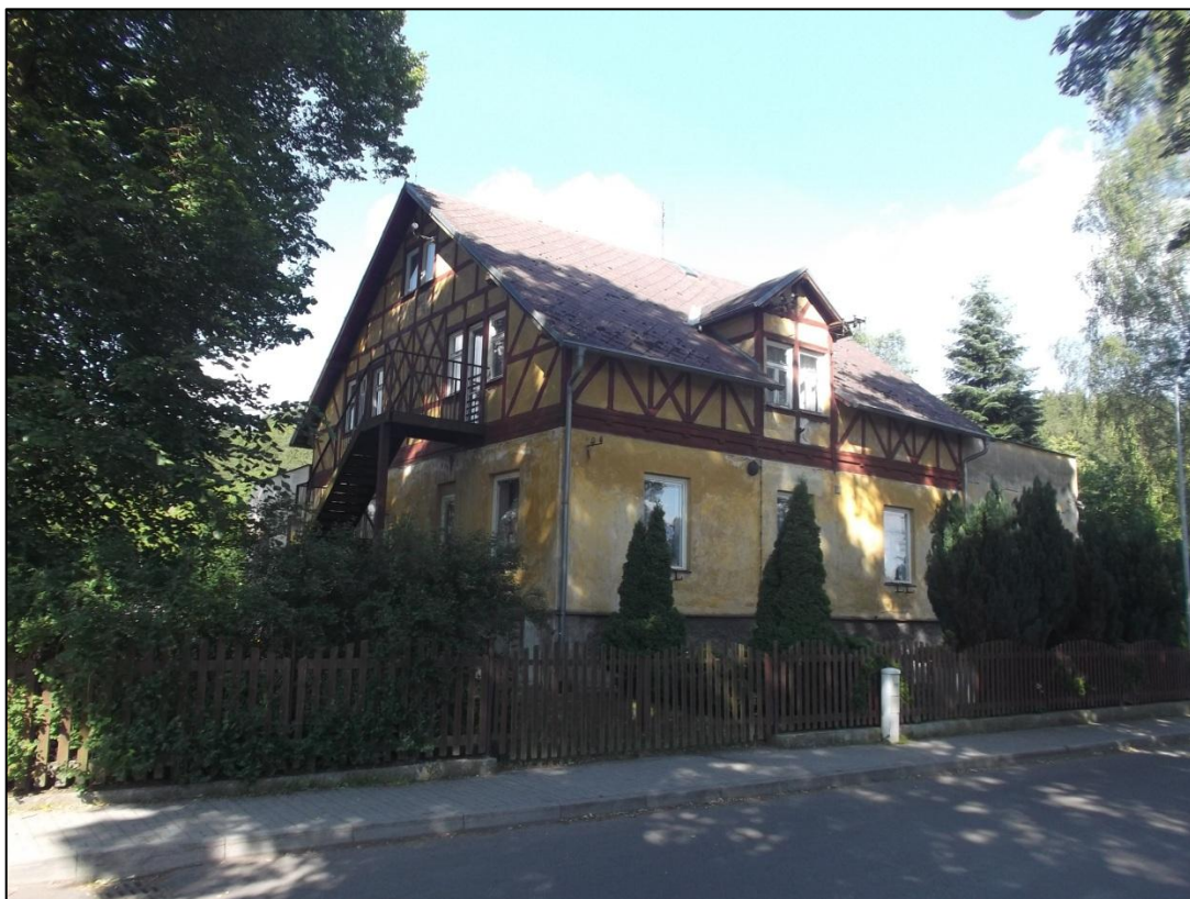
Fotografie č. 47 a 48 – Hrázděná budova školky ve Školní ulici. 115
