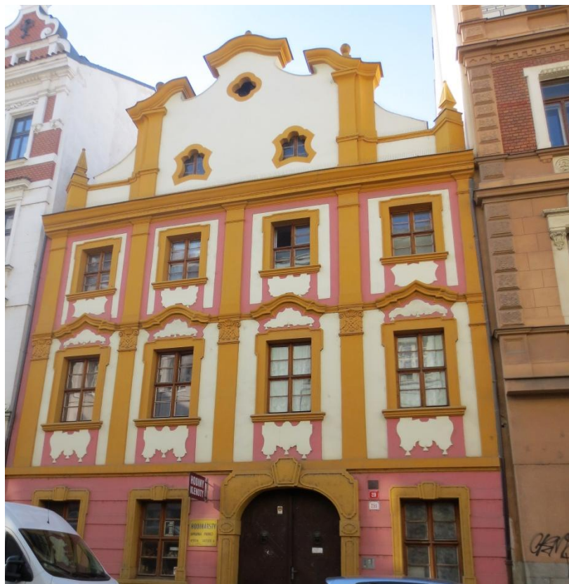
Obrazová příloha č. B5: Dům č. p. 251 v Sedláčkově ulici
