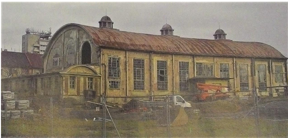
Obrazová příloha č. C6a: Budova darovaná projektu Techmania
