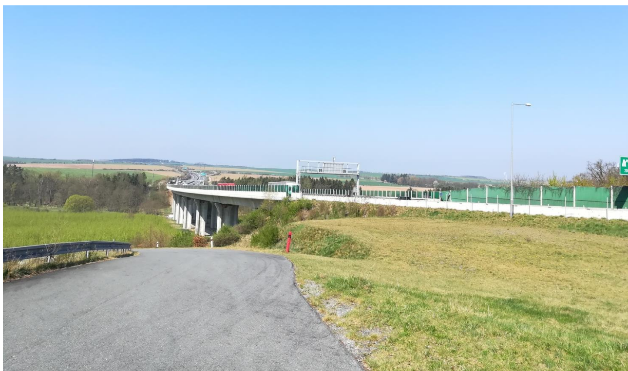
Obrázek č. 15 – Dálniční most přes Úhluvu Foto: Klára Tomrdlová
