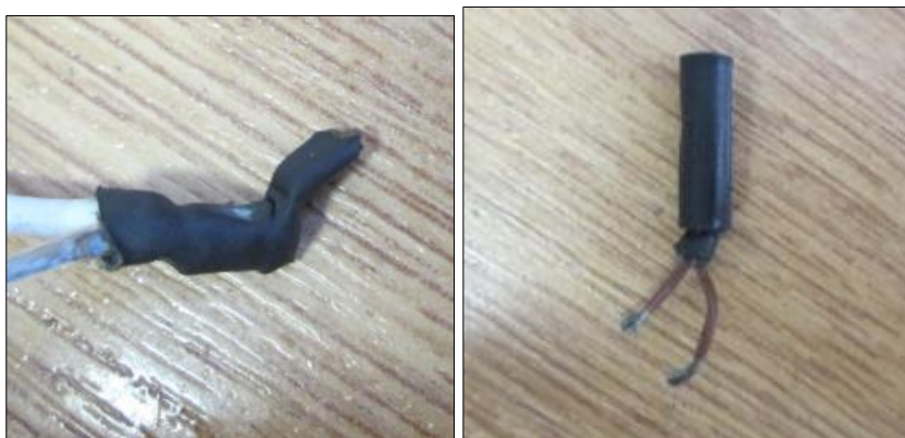
Obr. 30 špatný elektrický kontakt-nesprávný splicing
