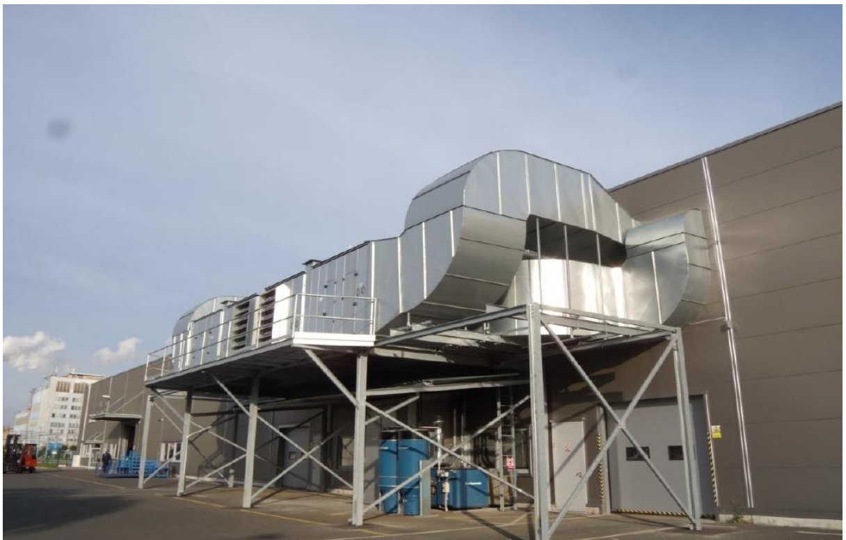
Obr. 15: Sestava vtažné jednotky + filtrační zařízení z haly
