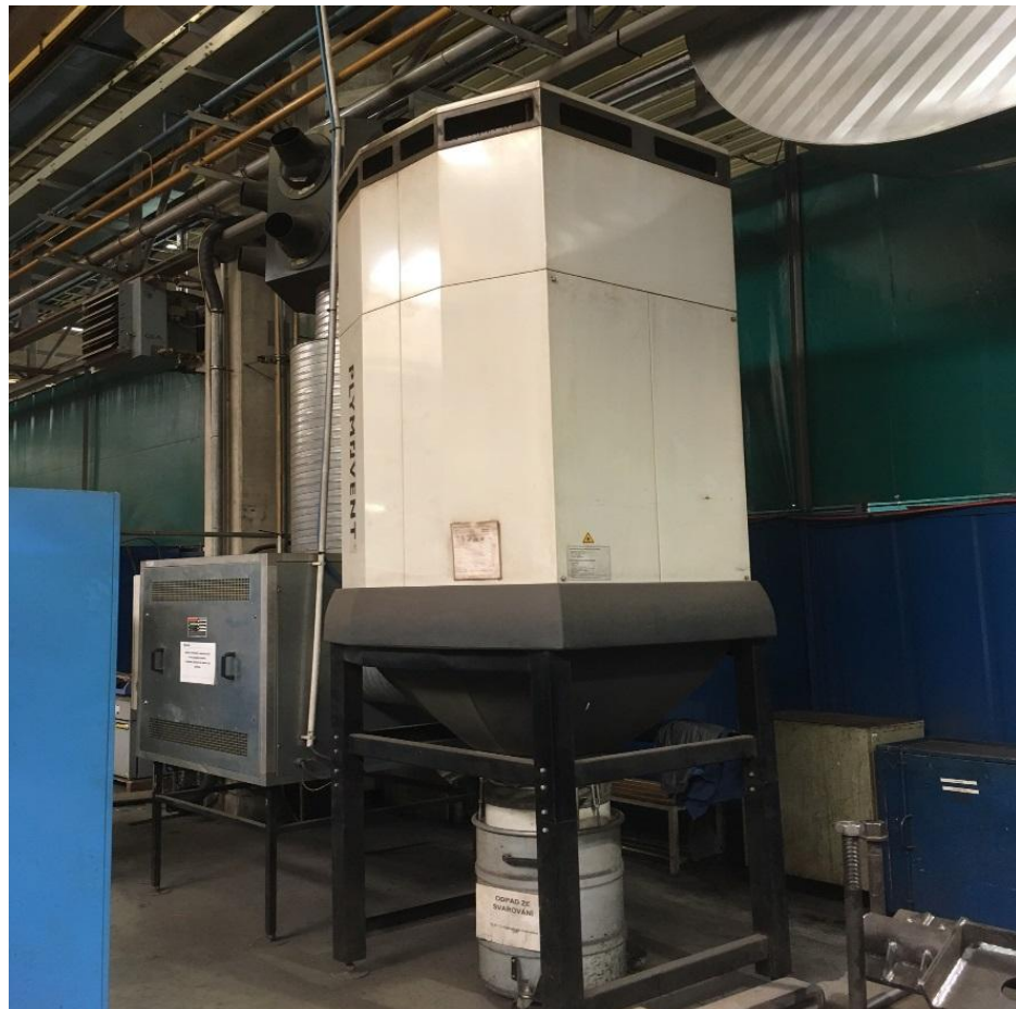
Obr. 14: Vzduchová pračka značky Plymovent – systém DILUTER
