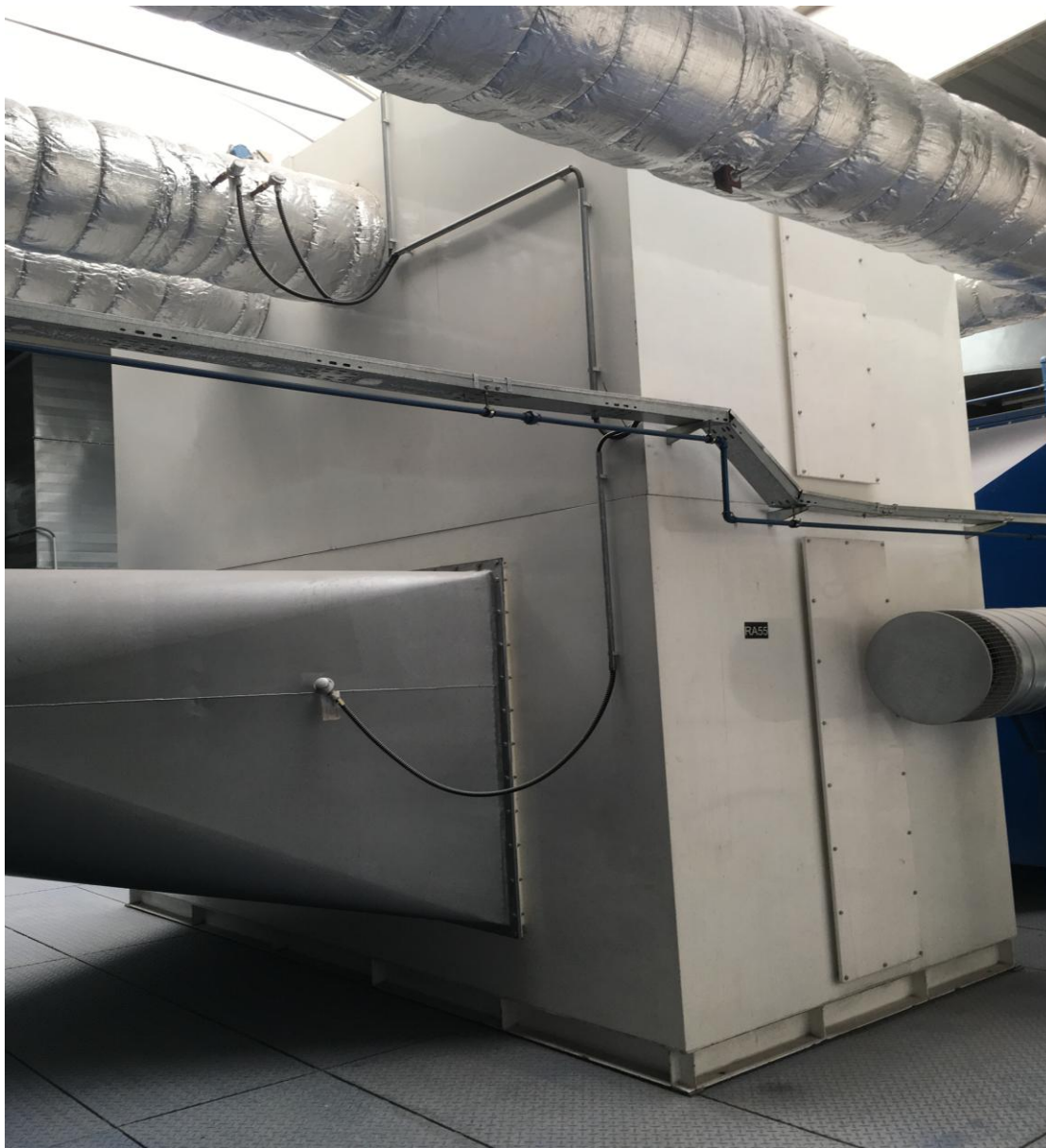
Obr. 17: Rotační koncentrátor
