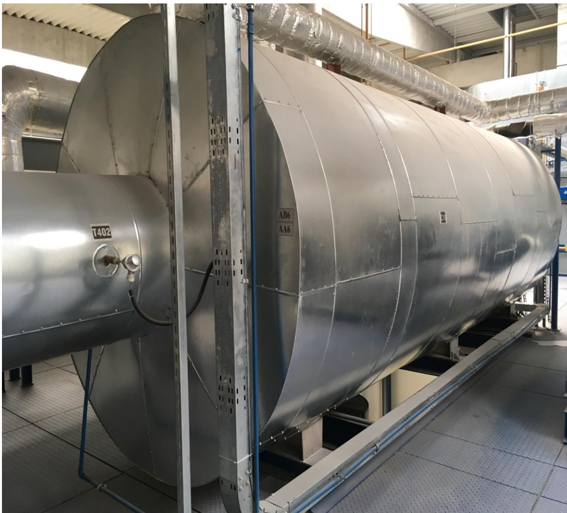
Obr. 18: Termicko-oxidační jednotka
