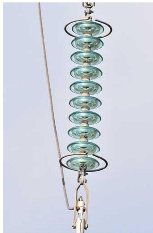
Obr. 6.5 – Skleněný diskový izolátor (převzato z [39])
