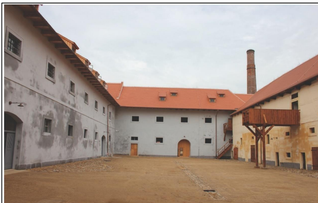
Příloha č. 61 – Hospodářský dvůr (dolejší dvůr) po dokončení obnovy v roce 2015. Zdroj: Národní technické muzeum, Centrum stavitelského dědictví Plasy.
