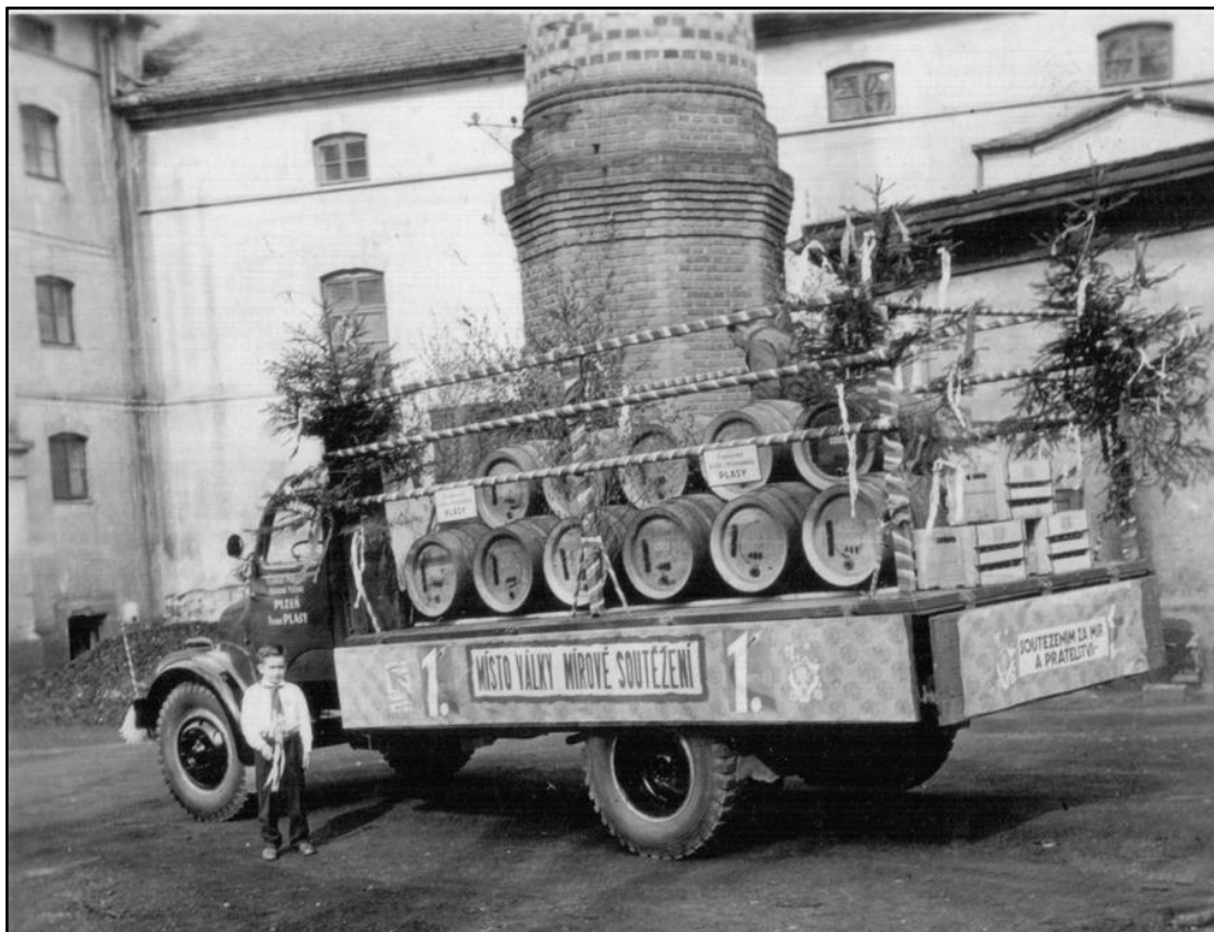
Příloha č. 80 – Klášterní pivovar v roce 1962. Zdroj: Národní technické muzeum, Centrum stavitelského dědictví Plasy.
