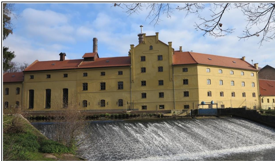
Příloha č. 23 – Pivovar v roce 2015 (pohled od řeky Střely). Zdroj: Národní technické muzeum, Centrum stavitelského dědictví Plasy
