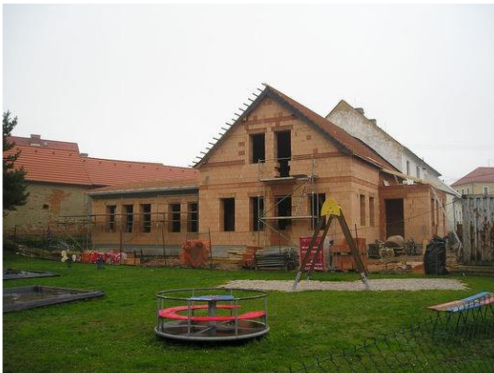
Obrázek 16: Stavba v prosinci 2012
