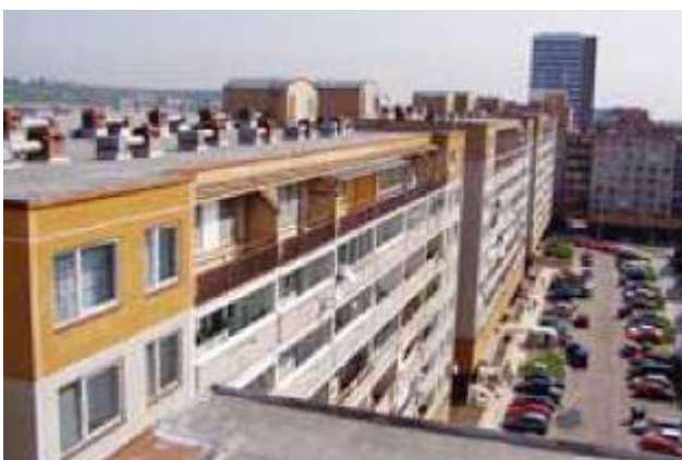
Obrázek 37- Atika dvouplášťové střešní konstrukce [3]
