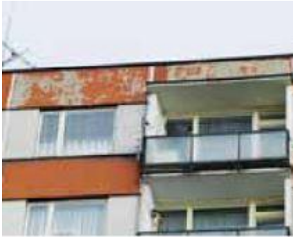
Obrázek 38 - Dílec posledního podlaží budovy T 06 B současně tvořící střešní atiku [3]
