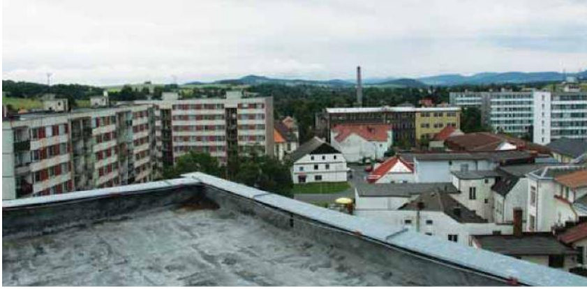
Obrázek 35 - Atika jednoplášťové střešní konstrukce [3]
