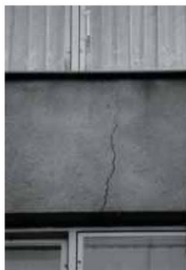
Obrázek 32 - Svislá trhlina [3]
