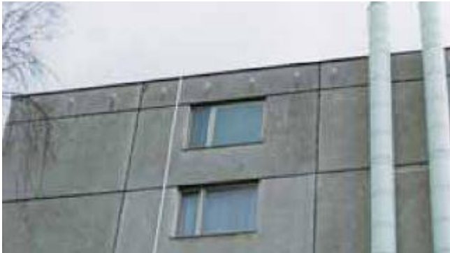
Obrázek 39 - Atikový dílec nad štítovou stěnou [3]
