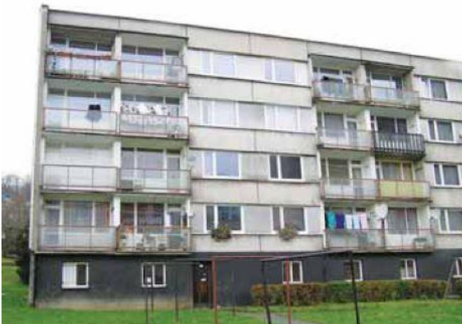
Obrázek 40 - Atikové dílce řemenového obvodového pláště [3]
