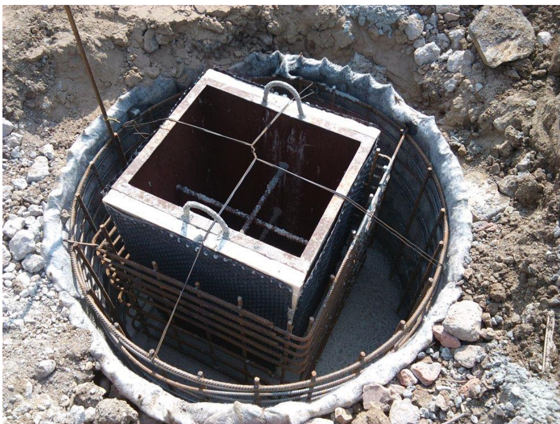
Obrázek – rozšířená hlavice piloty
