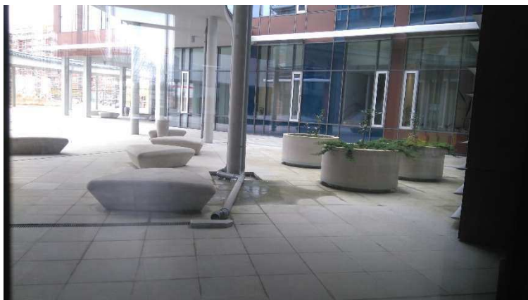
Obrázek 62 Pohled na střechu č. 25 z budovy
