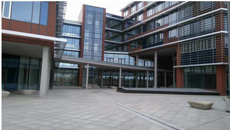
Obrázek 61 Pohled na střechu č. 25
