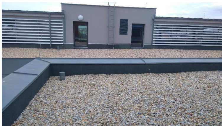
Obrázek 41 Pohled na střechu č. 7 a 6
