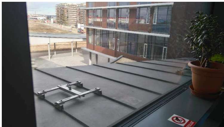
Obrázek 35 Pohled na střechu č. 3
