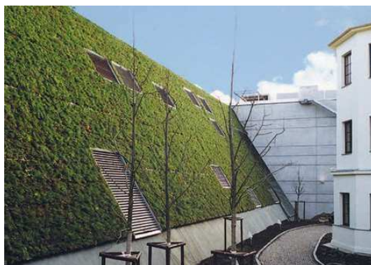
Obrázek 6 Pohled na ozeleněný plášť se sklonem 58° [ http://stavba.tzb-info.cz/strechy/7708-stresni-zelen-na-strme-sikme-plose-jako-prirodni-prostor-ve-meste ]
