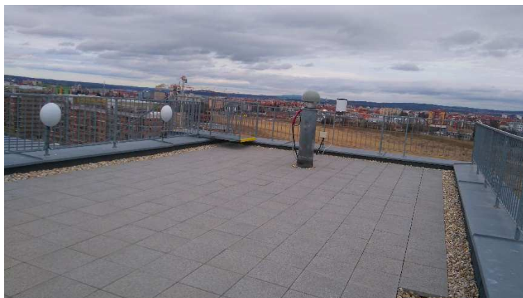
Obrázek 45 Pohled na střechu č. 11
