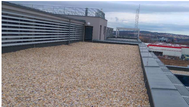
Obrázek 49 Pohled na střechu č. 15
