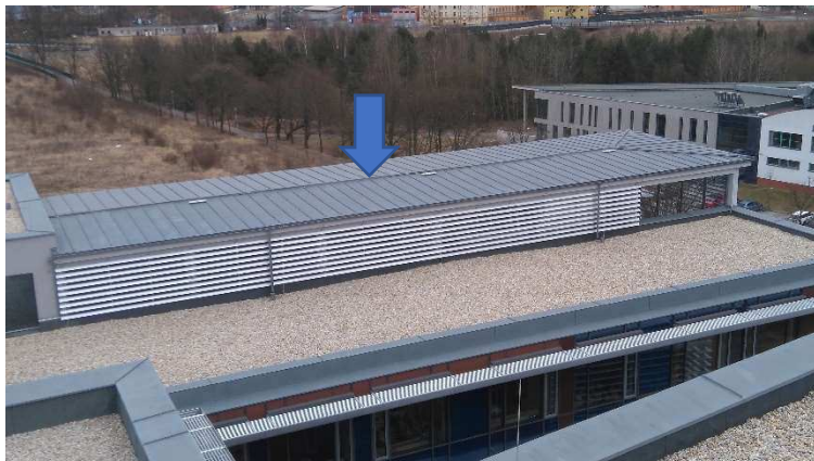
Obrázek 54 Pohled na střechu č. 19
