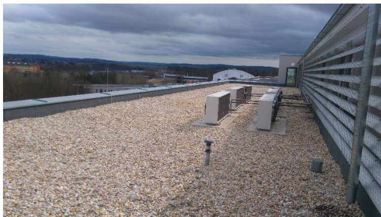
Obrázek 36 Pohled na střechu č. 4
