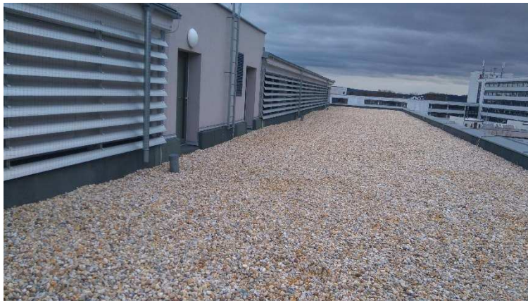
Obrázek 38 Pohled na střechu č. 6
