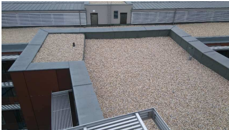
Obrázek 51 Pohled na střechu č. 17a a 17b
