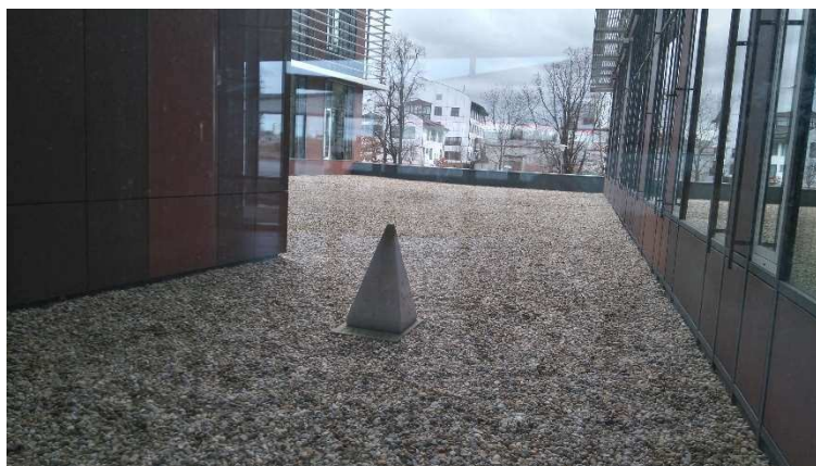
Obrázek 32 Pohled na střešku č. 1a a 1b
