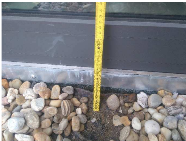
Obrázek 88 Foto dveří střechy č. 5
