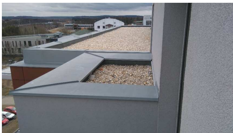
Obrázek 42 Pohled na střechu č. 8
