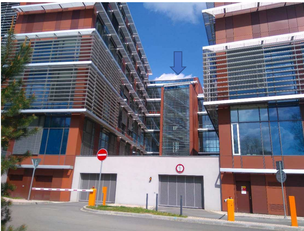
Obrázek 114 Foto budovy – jižní pohled, s vyznačením střechy č. 9
