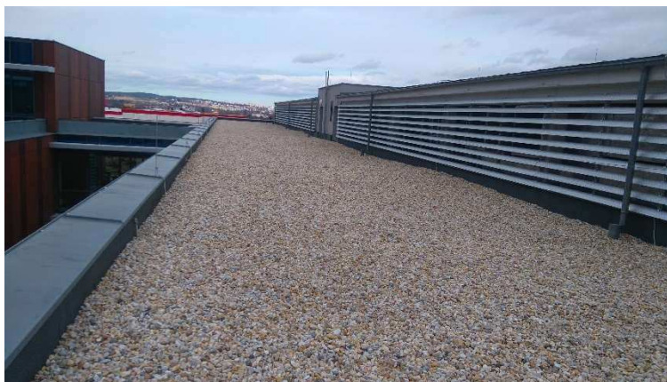
Obrázek 39 Pohled na střechu č. 6
