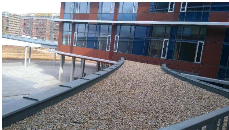
Obrázek 34 Pohled na střechu č. 2b
