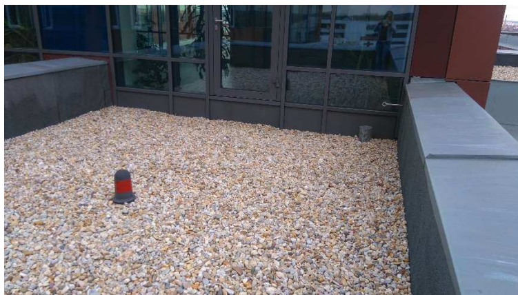
Obrázek 43 Pohled na střechu č. 9
