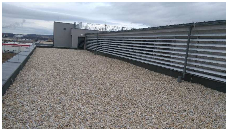
Obrázek 50 Pohled na střechu č. 16
