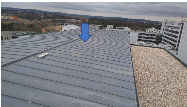
Obrázek 55 Pohled na střechu č. 20
