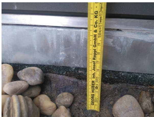
Obrázek 94 Foto dveří střechy č. 15
