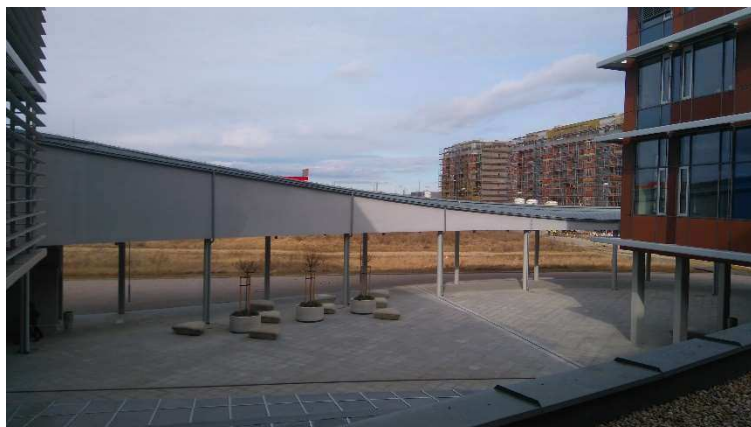
Obrázek 59 Pohled na střechu z terasy (střechy) 2a
