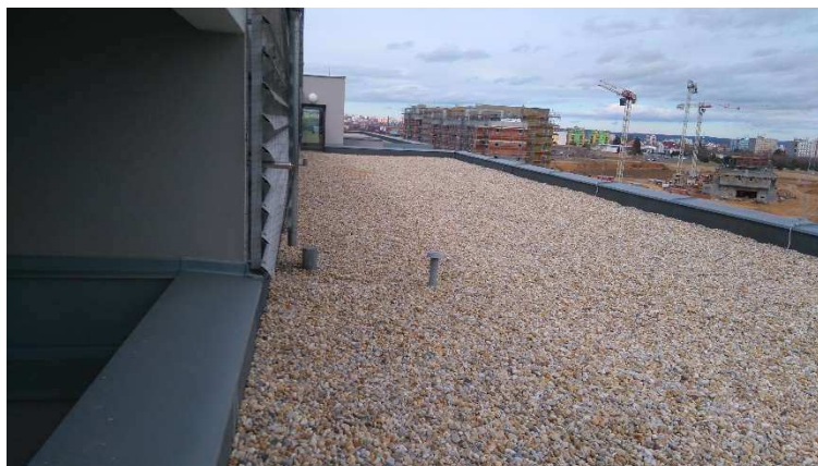
Obrázek 37 Pohled na střechu č. 5
