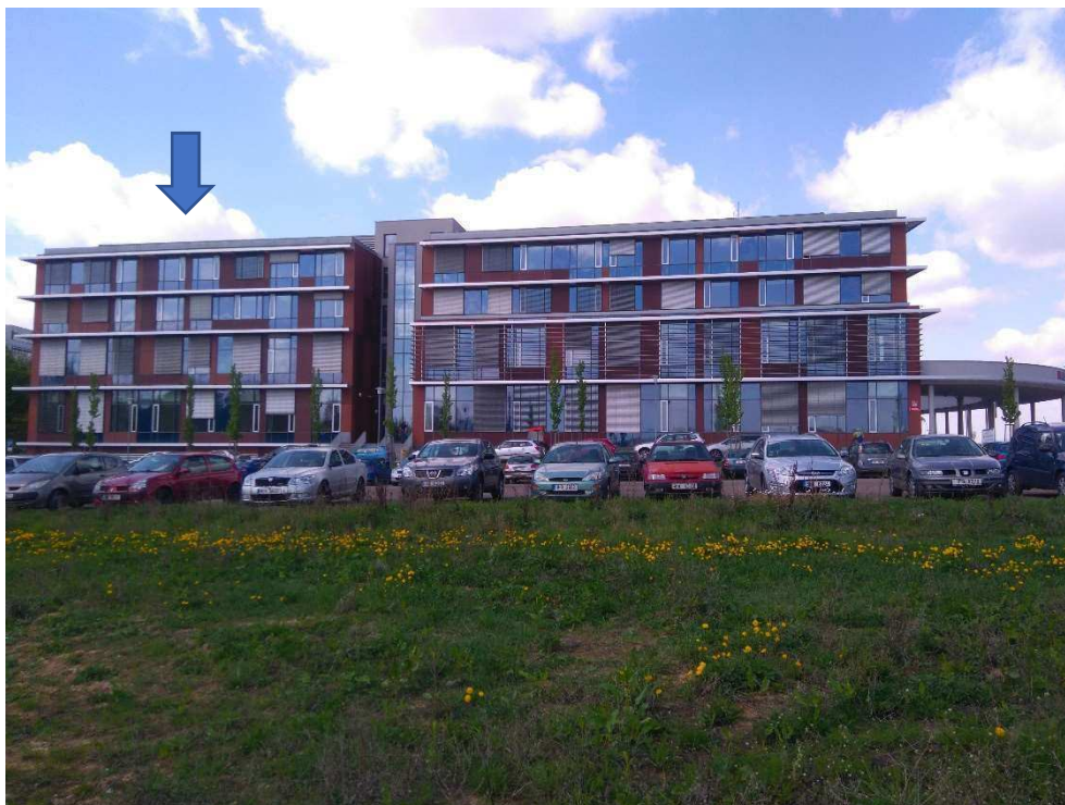
Obrázek 115 Foto budovy – východní pohled, s vyznačením střechy č. 5
