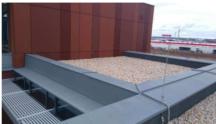
Obrázek 40 Pohled na střechu č. 7
