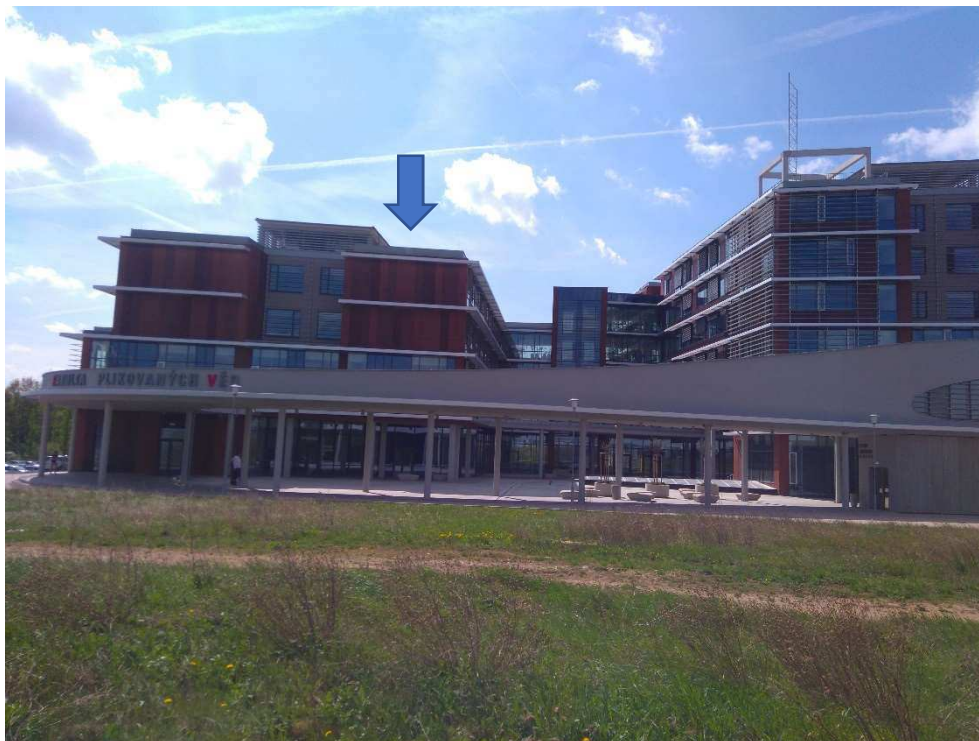
Obrázek 109 Foto budovy – severní pohled s vyznačením střechy č. 6
