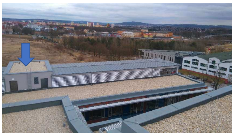
Obrázek 57 Pohled na střechu č. 22 a 19
