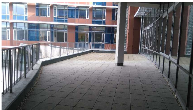
Obrázek 33 Pohled na terasu (střechu) č. 2a
