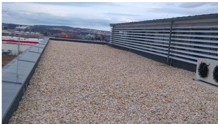
Obrázek 48 Pohled na střechu č. 11
