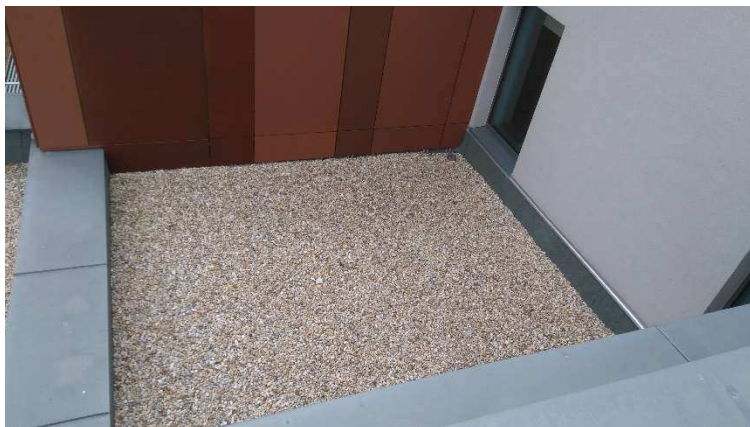
Obrázek 52 Pohled na střechu č. 17c
