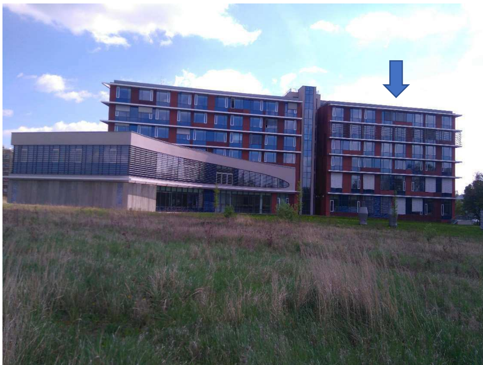
Obrázek 111 Foto budovy – západní pohled, s vyznačením střechy č. 16
