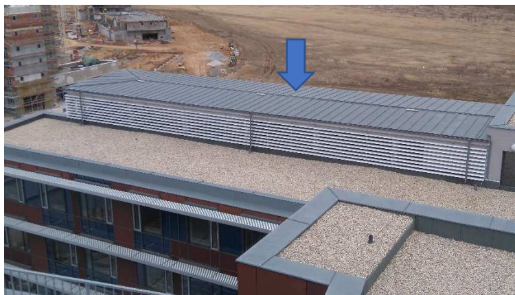
Obrázek 53 Pohled na střechu č. 18
