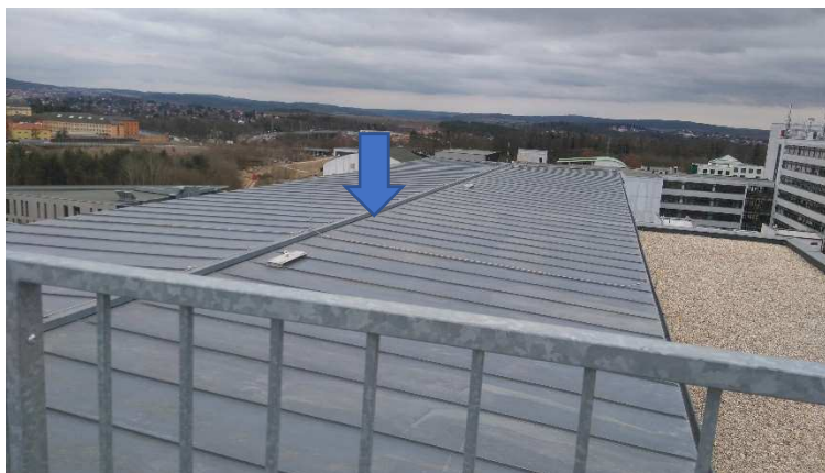
Obrázek 56 Pohled na střechu č. 21
