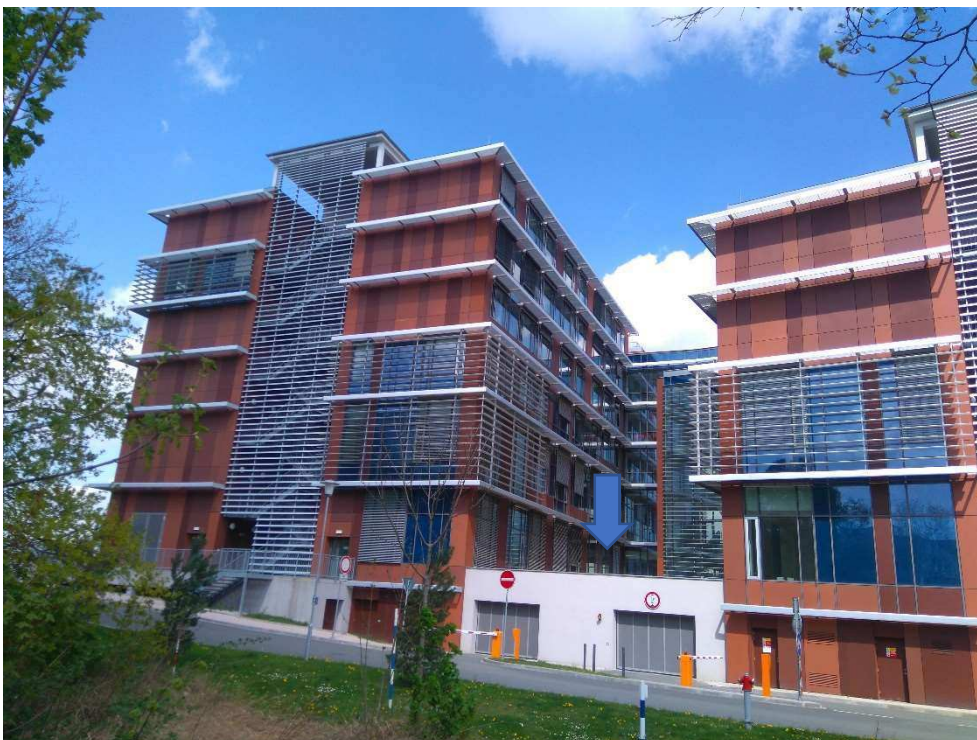
Obrázek 113 Foto budovy – jižní pohled, s vyznačením střechy č. 1
