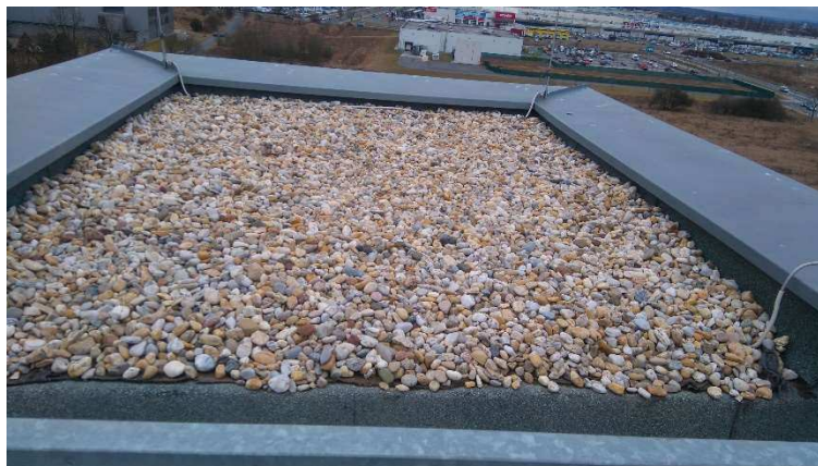
Obrázek 46 Pohled na střechu č. 12
