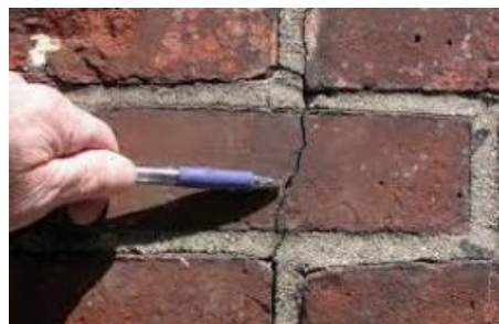
Obr. 4.10. Tahová svislá trhlina v cihle [33]
