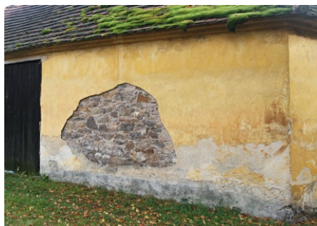
Obr. 4.4. Vliv vlhkosti
