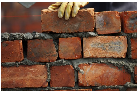
Obr. 4.6. Špatná vazba a promaltované spáry
