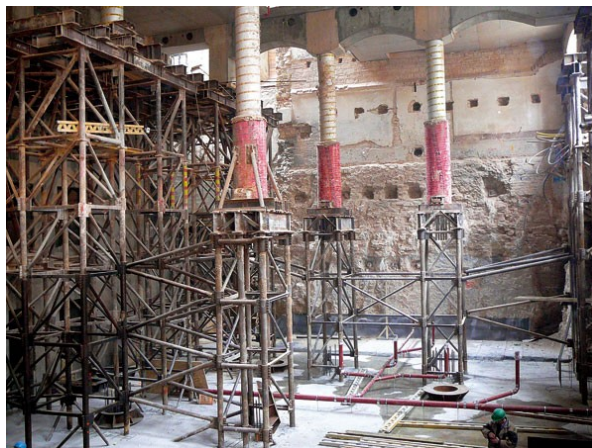
Obr. 5.2. Dočasné zajištění sloupů [37]
