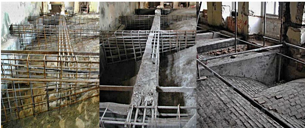
Obr. 5.10. Zpevnění klenby žebry [42]
