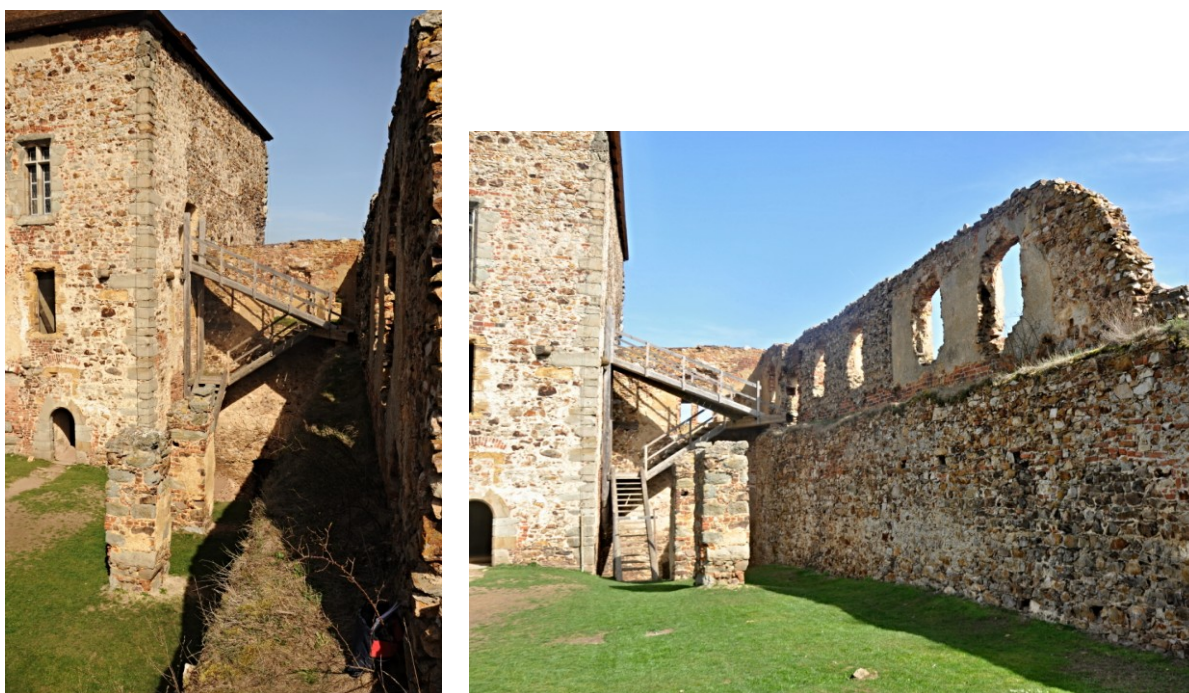
Obr. 6.2. Stávající stav venkovního schodiště u Královského paláce
