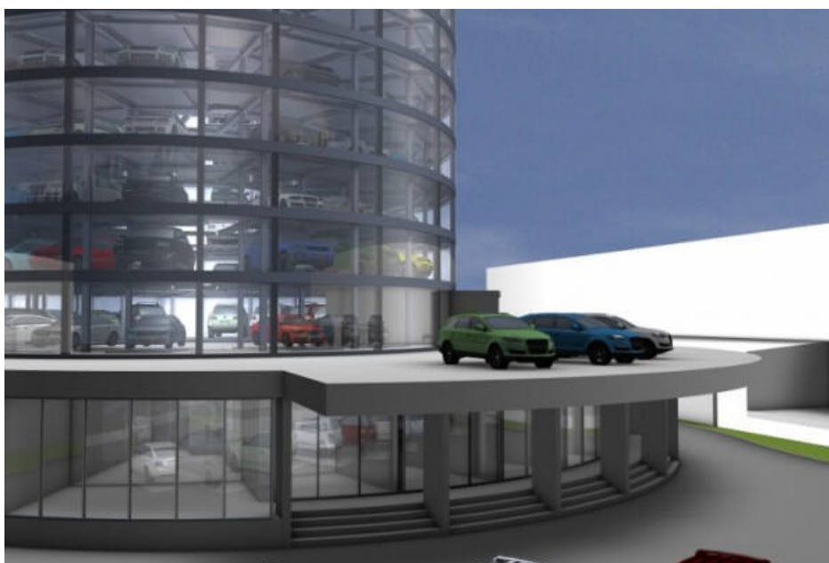
Obr. 14: Kruhové silo, ocelová konstrukce, 1.NP železobetonové (Autosalon)
