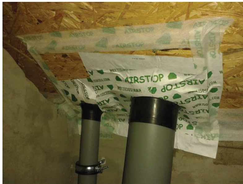
Obrázek 10 Provedení prostupů skrz vzduchotěsnou obálku
