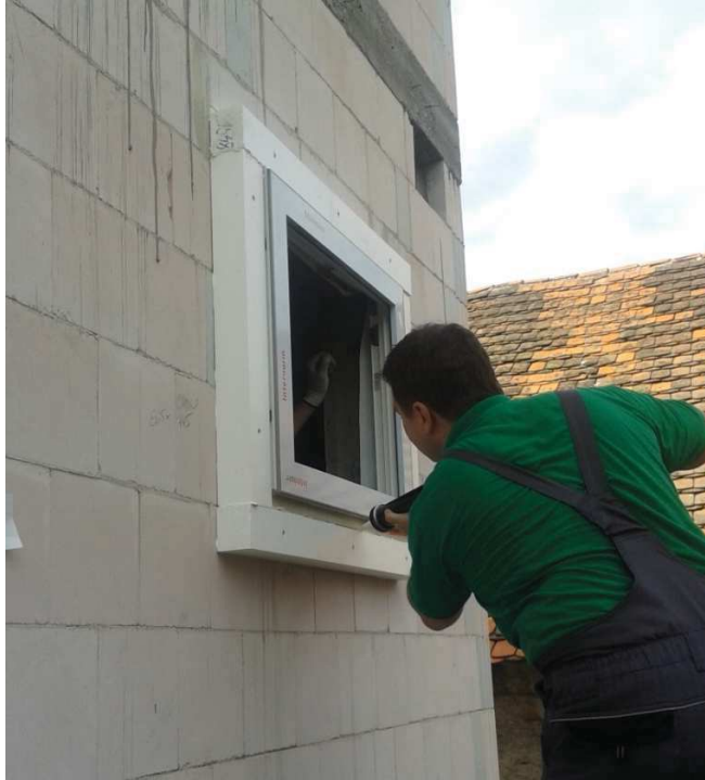
Obrázek 6 Předsazená montáž výplní otvorů
