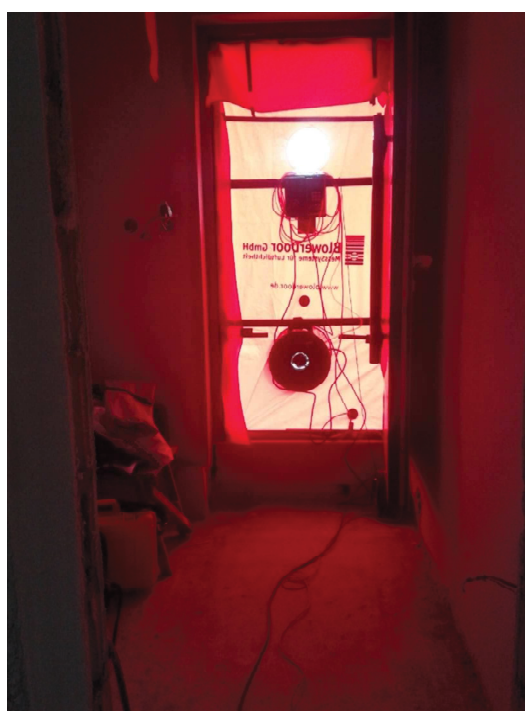
Obrázek 12 Blower door - test
