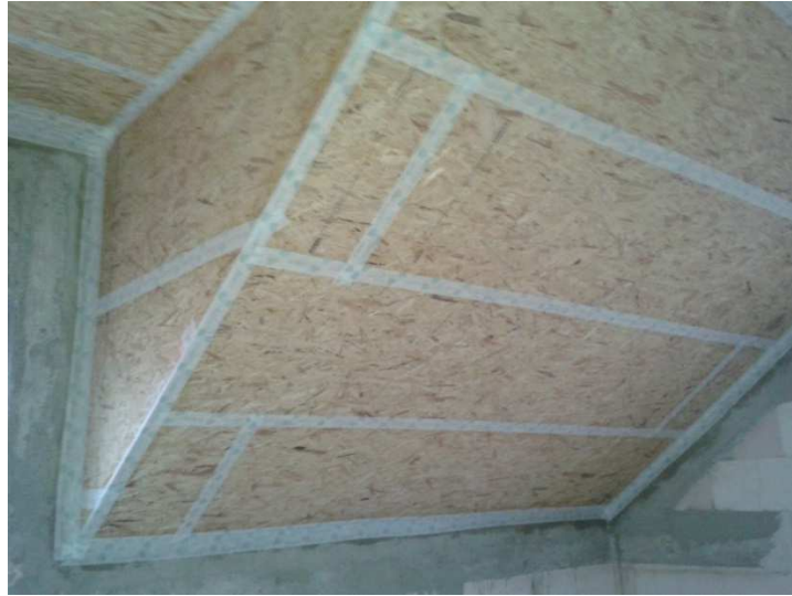
Obrázek 9 Přelepení spáry pomocí pásky AIRSTOP
