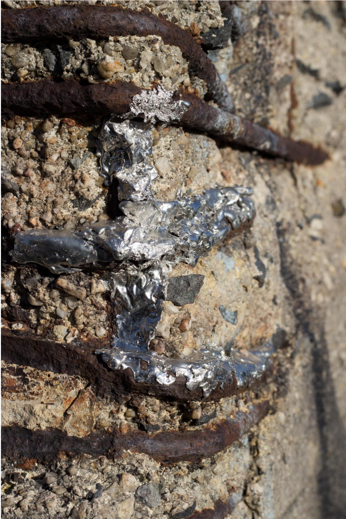
Segment XI – střecha, detail 65
