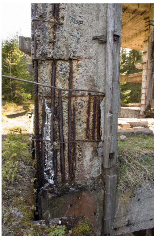
Segment VIII – 2. patro, po realizaci 59
