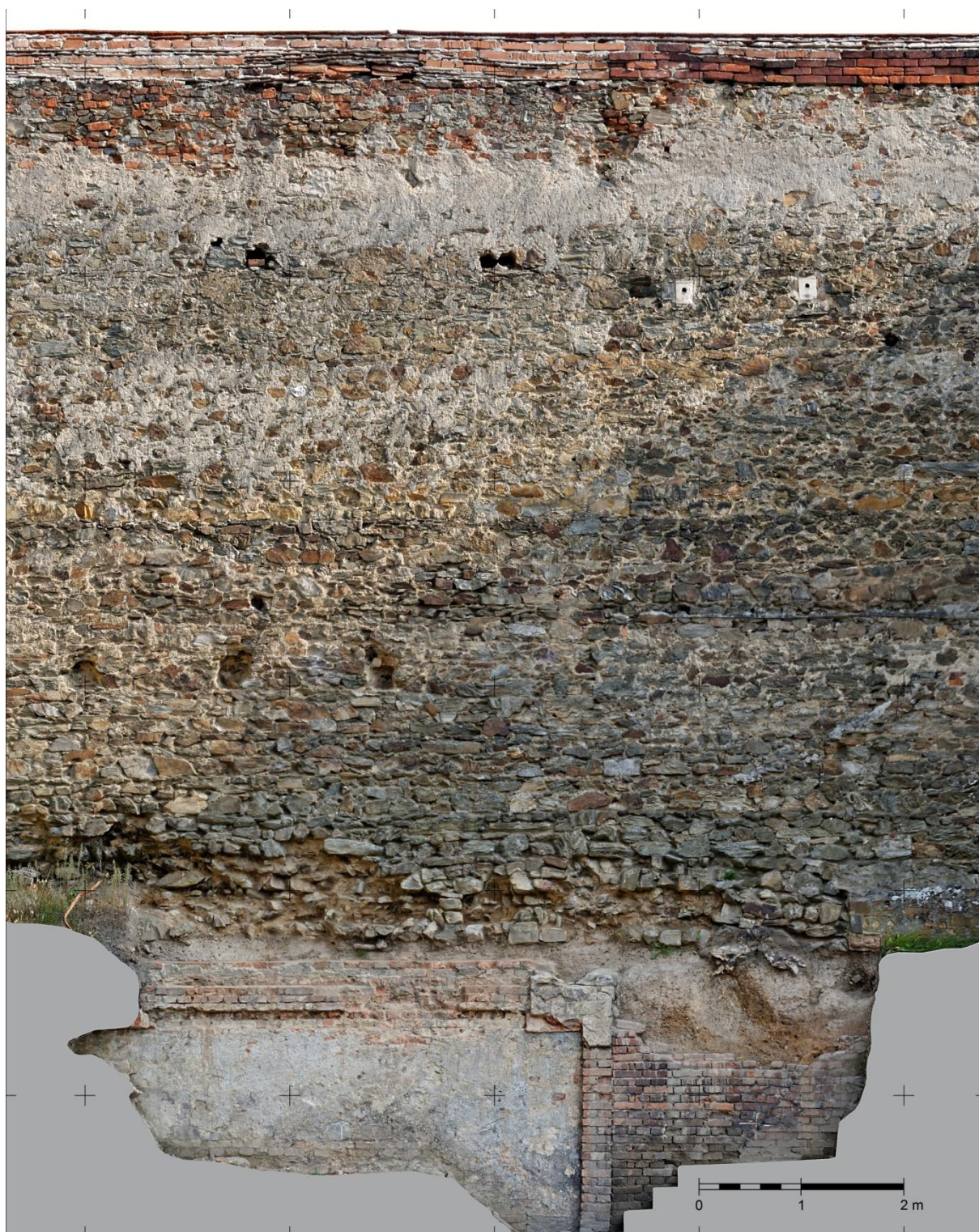
Příloha 26: Fotogrammetrická dokumentace městského opevnění, ke kterému byl přistavěný dům Georga Kummerera ( Hlavenka a Vidman 2016 )
