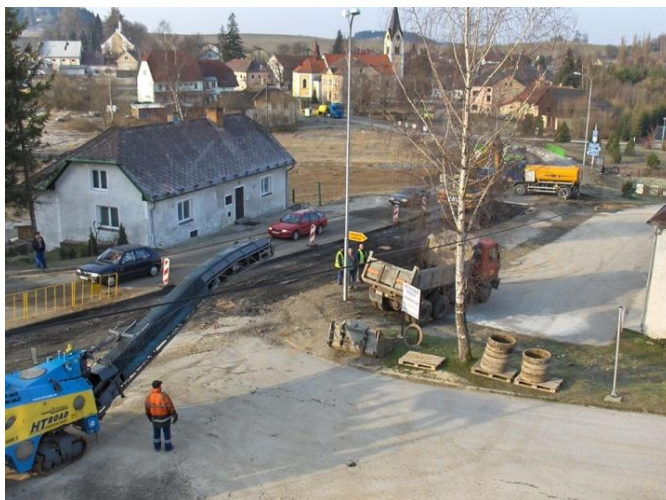
Obr. 14 – výstavba nové silniční komunikace Zdroj: Kronika obce Černá v Pošumaví: Facebook – stránka
