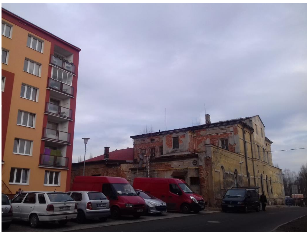
Obr. 14 Objekt bývalého Hotelu
