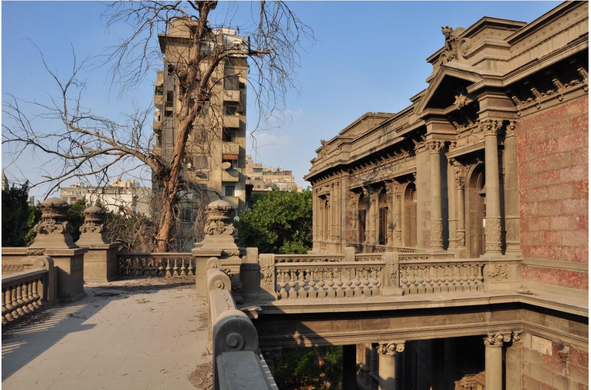
↑ Obr. 14: Tamtéž, terasa na střeše jednoho z bočních křídel budovy.
