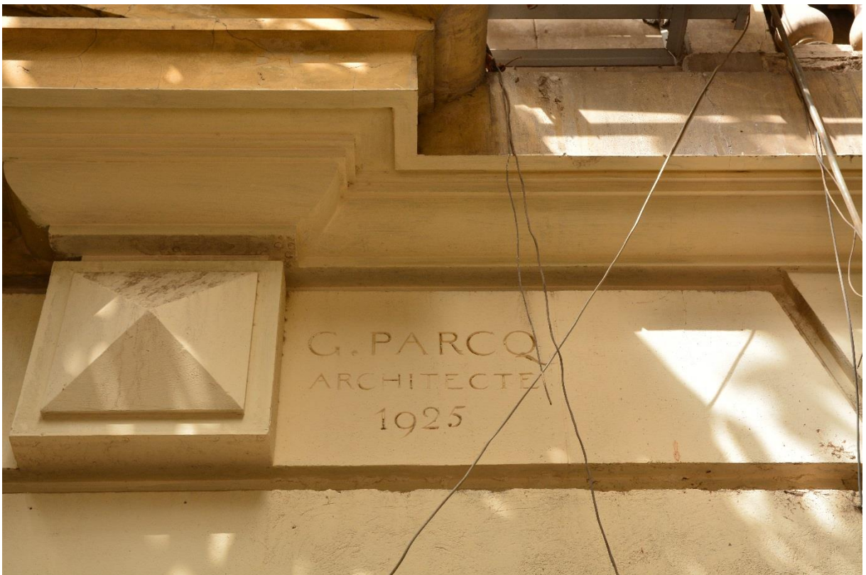
↓ Obr. 144: Tamtéž, jméno architekta vyryté do střeňy budovy.
