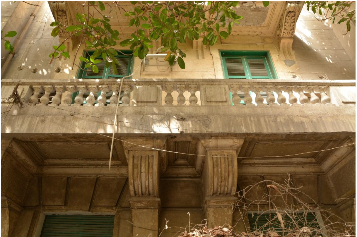
↑ Obr. 145: Tamtéž, balkon s balustrádou.
