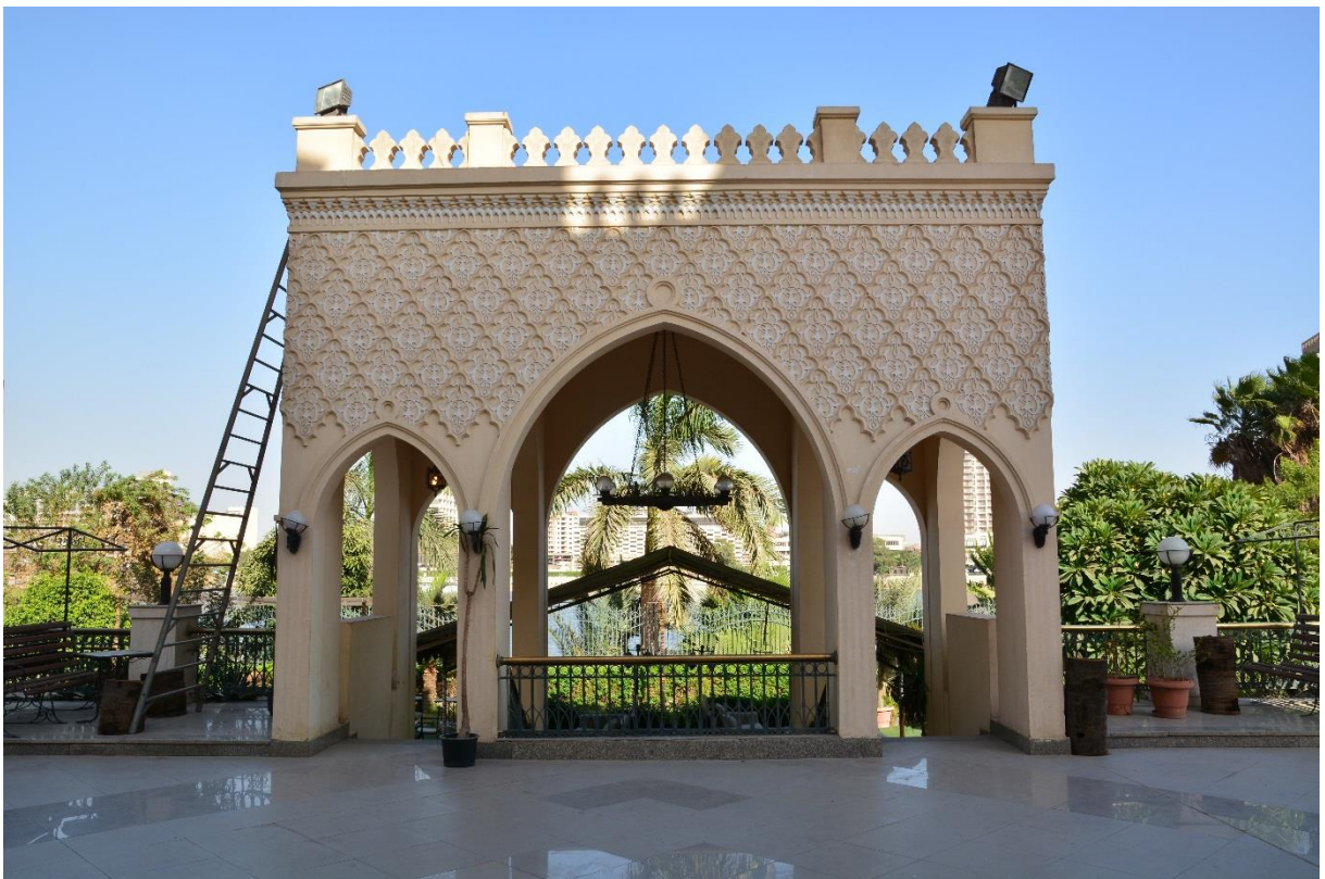
↓ Obr. 86: Altánek zastřešující schodiště vedoucí do zahrady na břehu Nilu.
