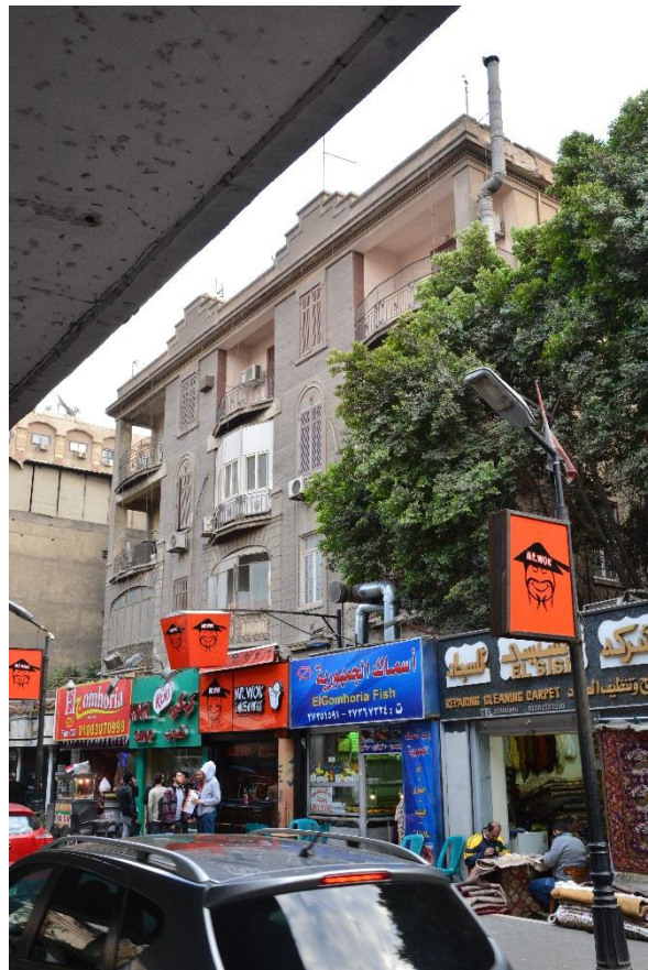
↓ Obr. 93: Tamtéž, boční pohled zpod mostu 15. května. Ve spodní části jsou vidět obchody obklopující budovu.
