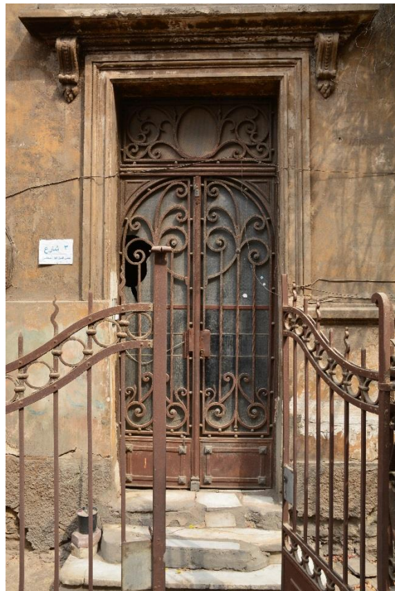
↓ Obr. 162: Tamtéž, vstupní prostor s litinovými dekorativními prvky.
