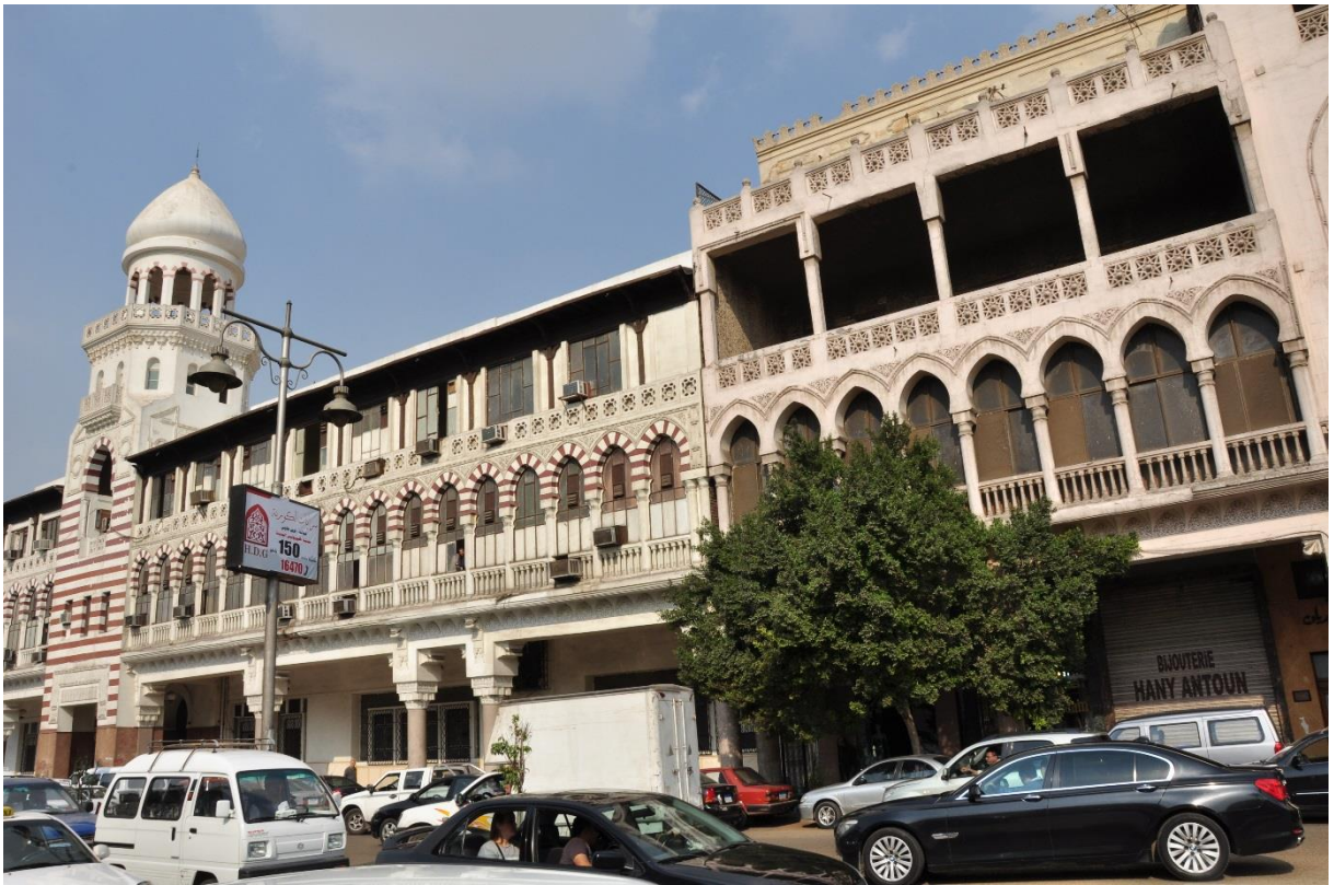
↑ Obr. 126: Vlevo budova ředitelství Heliopolské společnosti s nápadnou věží nad vstupním portálem.
