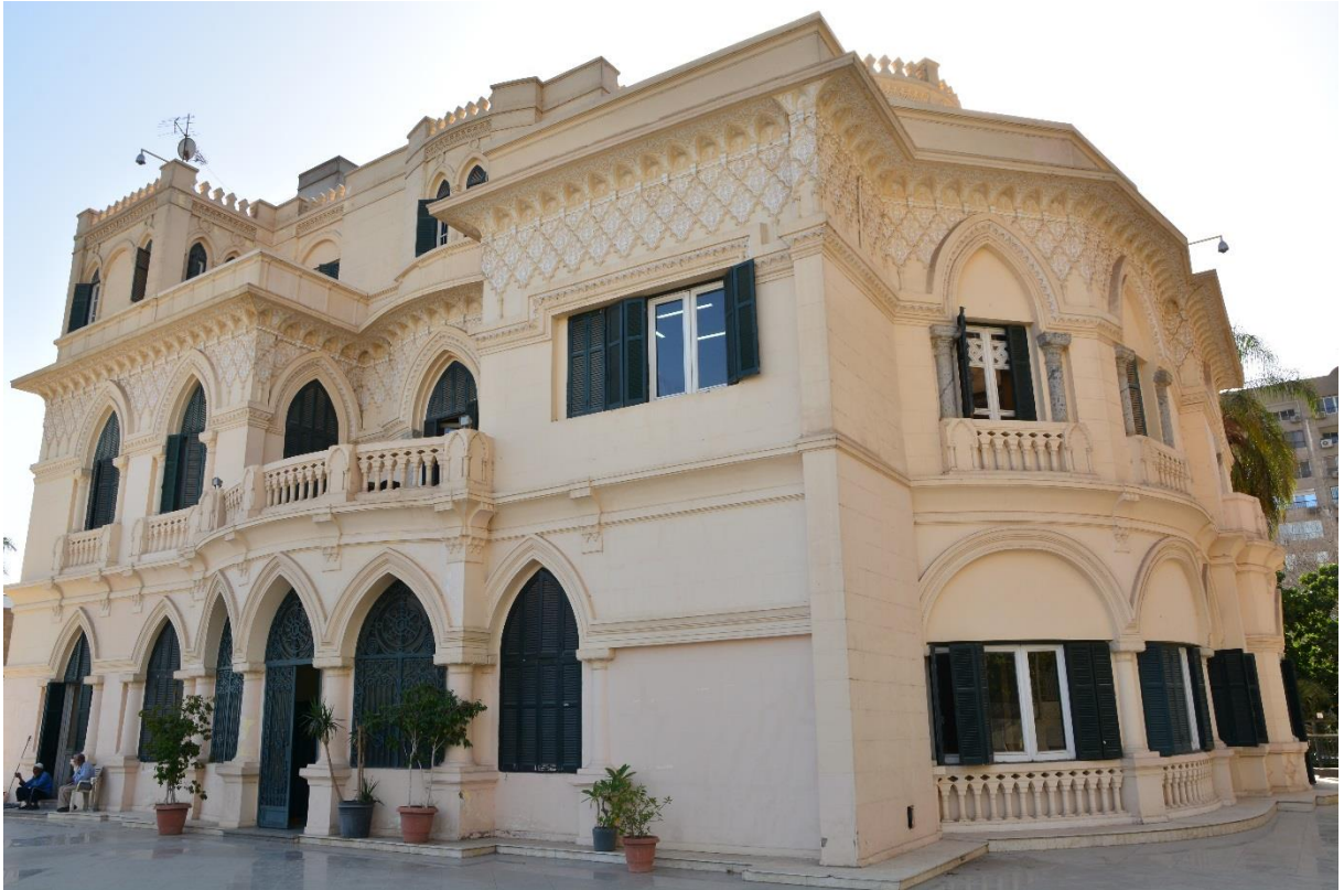
↑ Obr. 85: Tamtéž, pohled z prostoru za budovou na zadní část stavby.
