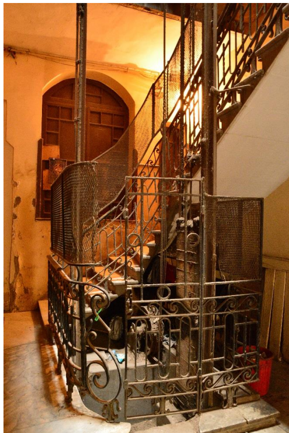
↓ Obr. 141: Tamtéž, výtahová šachta.
