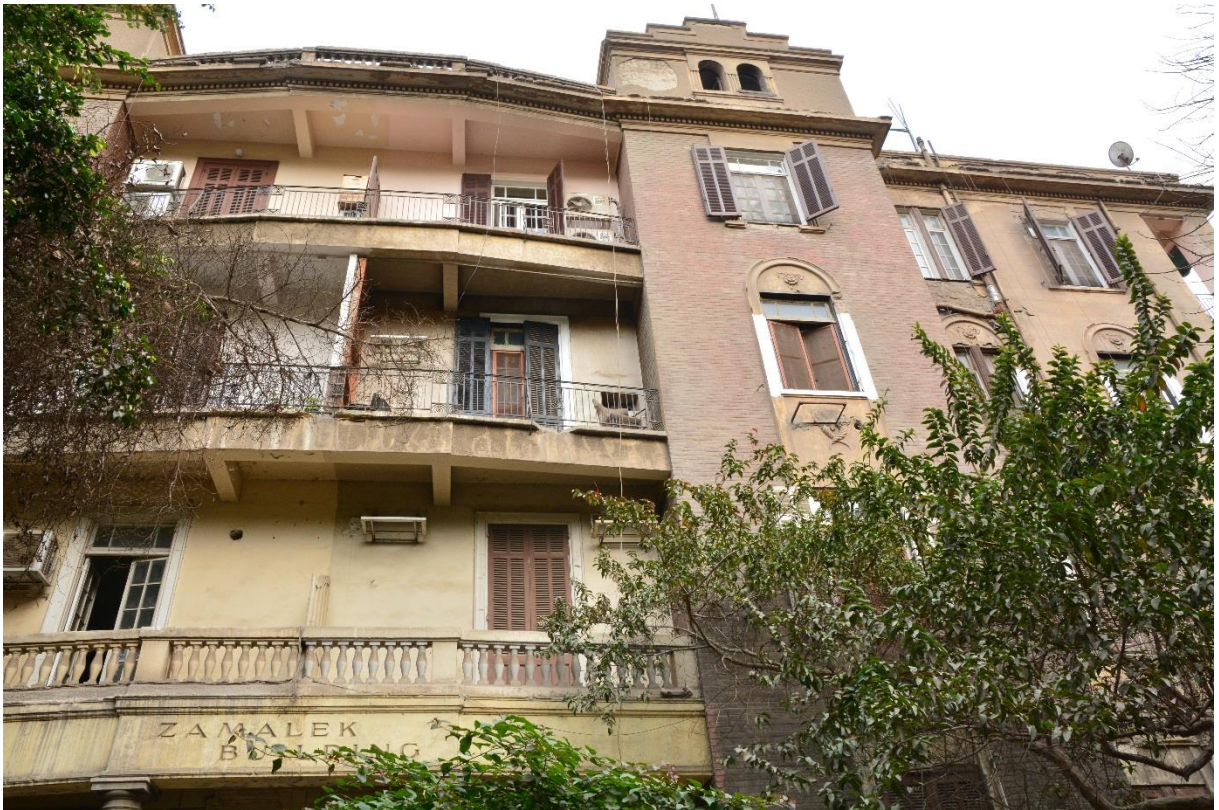
↑ Obr. 92: „Zamalek Building“, čelní pohled.
