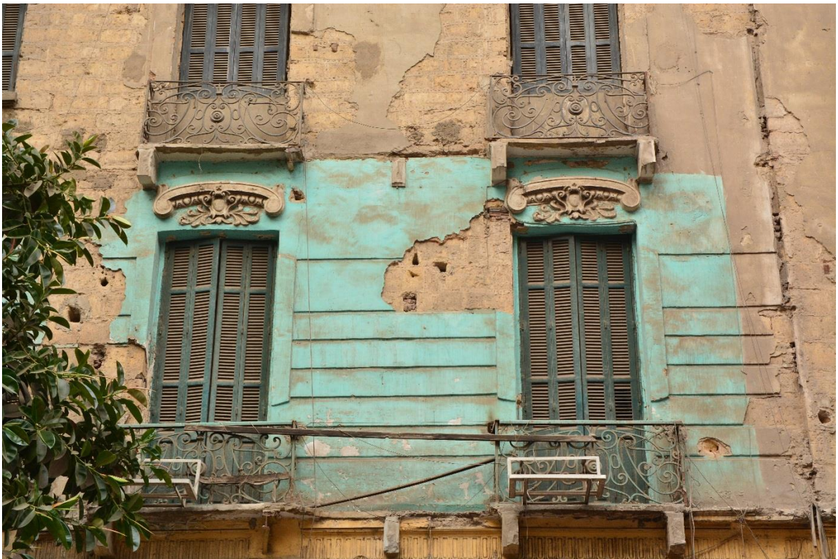
↓ Obr. 50: Litinové zábradlí balkonů domu č. 29 v ulici Hudy Ša'arawí.
