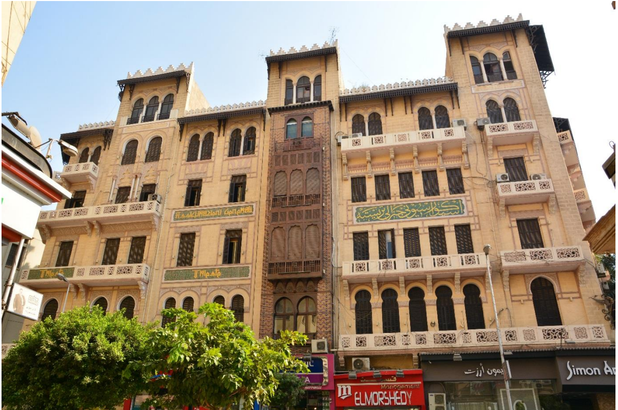
↑ Obr. 38: Budova Assicurazion Generali Trieste, čelní pohled.
