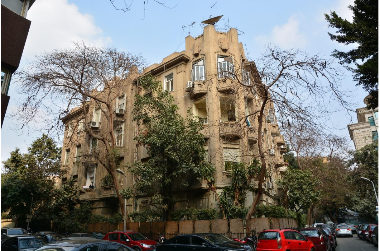
↑ Obr. 150: Dům č. 18 na ulici Dár aš-Šifá', celkový pohled.
