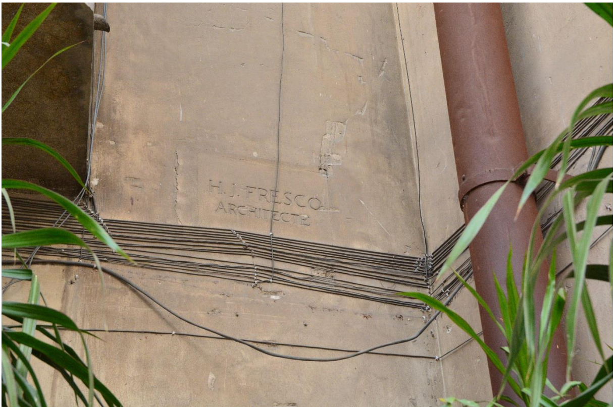
↓ Obr. 100: Jméno architekta vepsané do jedné ze zdí budovy.
