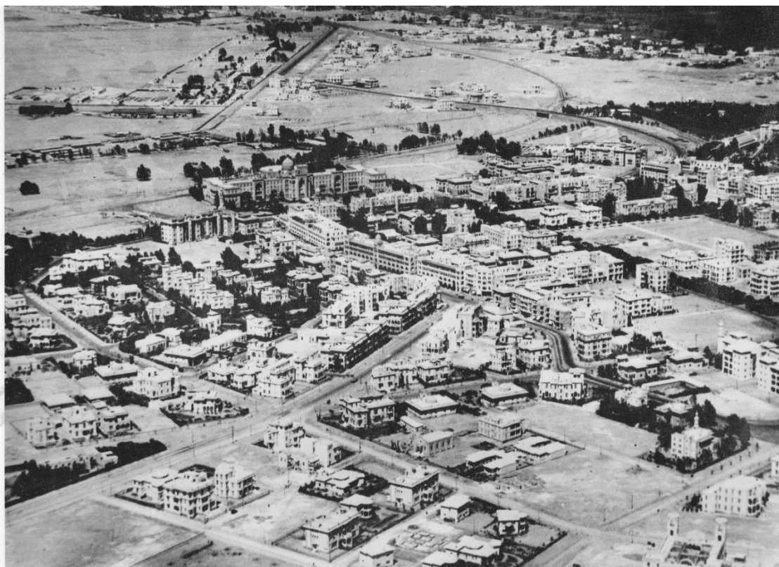
↑ Obr. 103: Fotografie z počátečních let existence Heliopole. Dominantní budova v pozadí = hotel Heliopolis Palace. Zdroj: Lehnert & Landrock.
