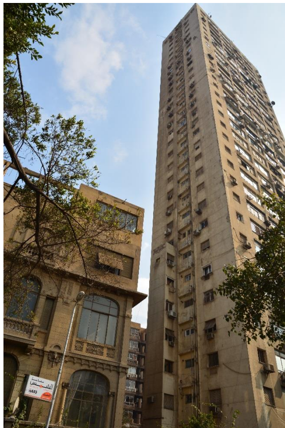
↓ Obr. 67: „Imárat Belmont“ v Garden City, druhá výšková budova v zemi.
