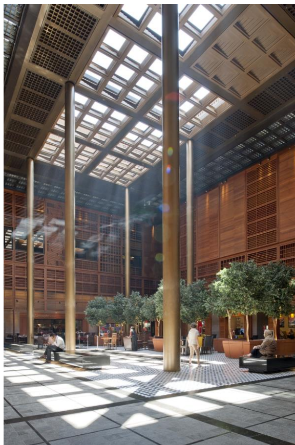
Príloha č.49, pohľad na zásuvné strešné panely, ktoré pomáhajú regulovať teplotu vo vnútri.
