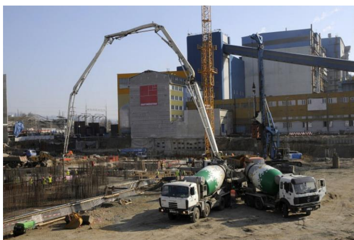
Obrázek 7- Ukládání betonové směsi
