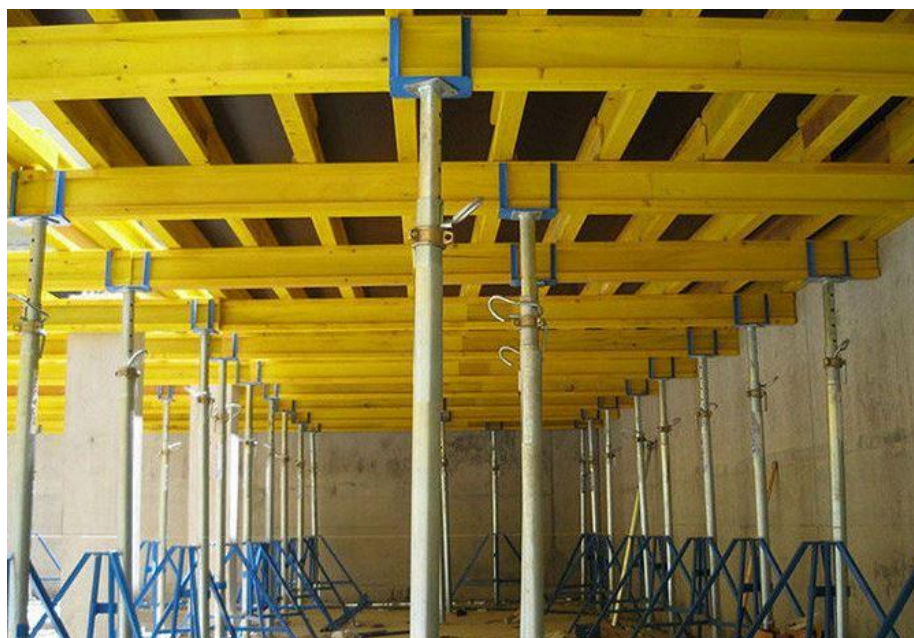
Obrázek 5 – Nosníkové bednění pro strop
