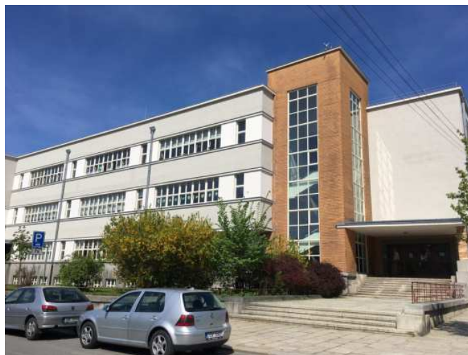
Obrázek 32: Budova ZŠ F.L. Čelakovského, Strakonice
