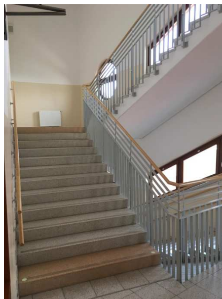
Obrázek 19: Schodiště, ZŠ Povážská
