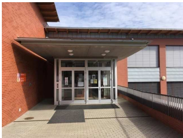
Obrázek 16: ZŠ Povážská, hlavní vchod
