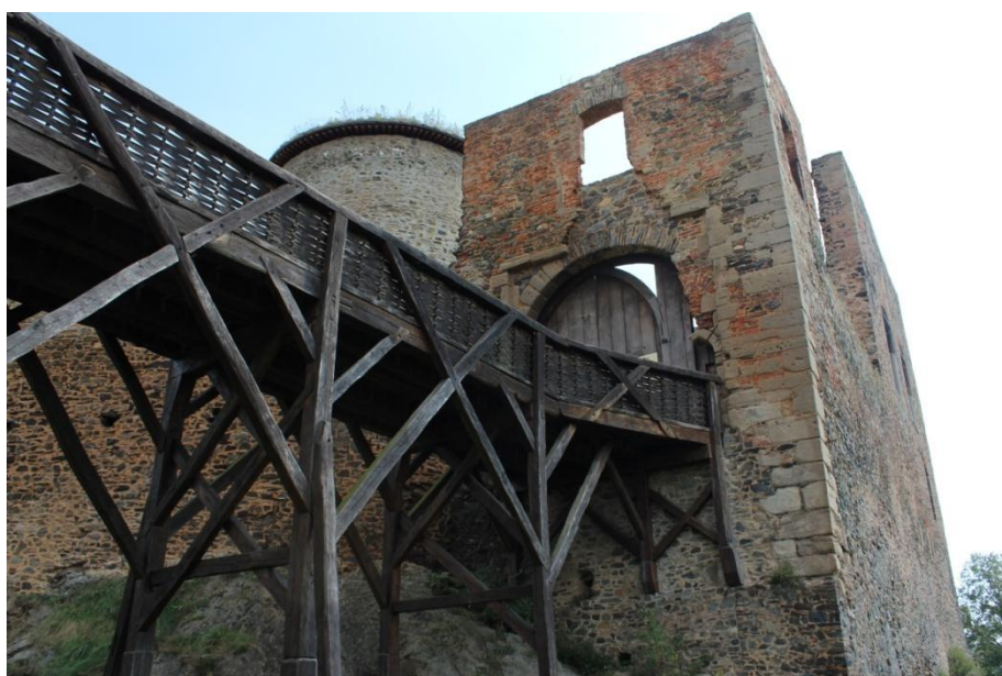
obr. 11 – Pohled na přemostění příkopu.
