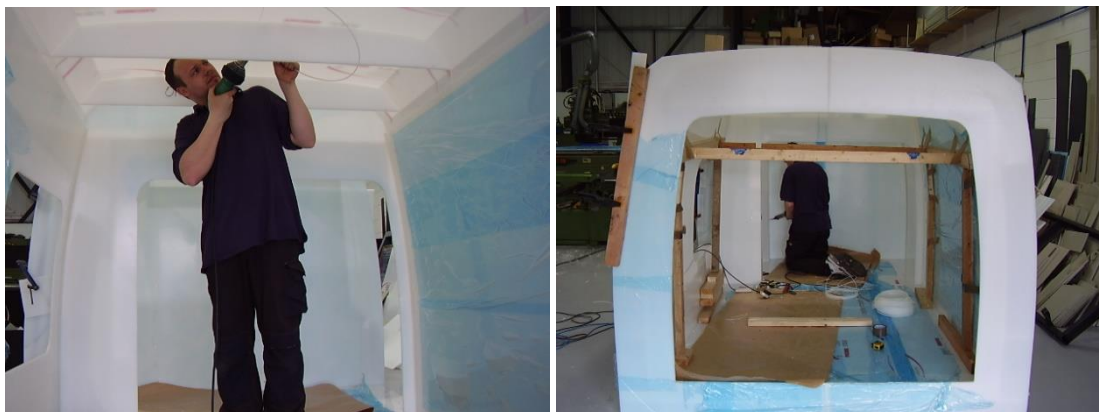
Obr. 4-16 Svařování plastové nástavby [27]
