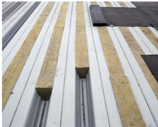
Obr. 4.4.1-4: Výplň kamennou minerální vlnou
