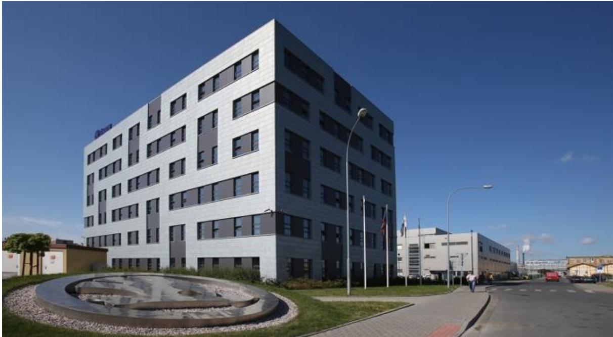
Obr. 1.1-1.: Pohled na budovu Škoda Transportation a.s. v Plzni
