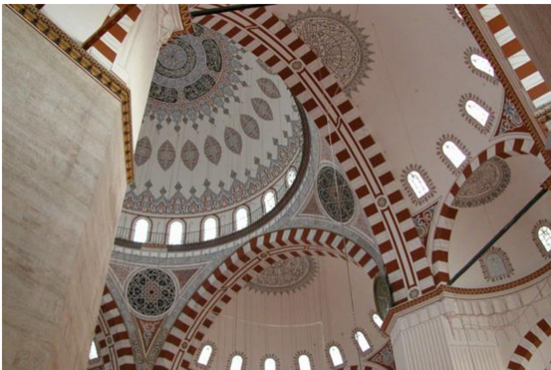
Obr. 19 Výrazné červeno-bílé podpěry kupole
