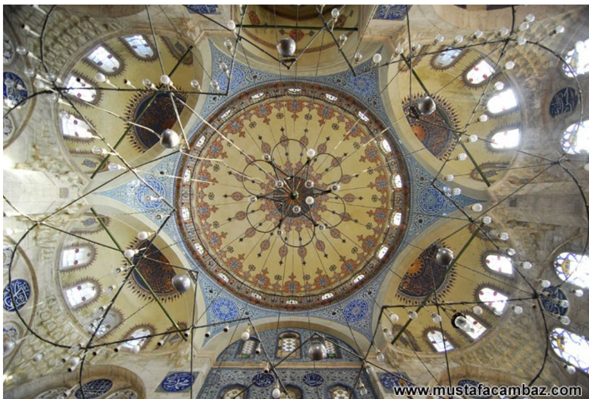
Obr. 35 Mešita Mehmeda Paši Sokoloviče v Kardiga. Ukázka dokonalejší hexagonální podstavy
