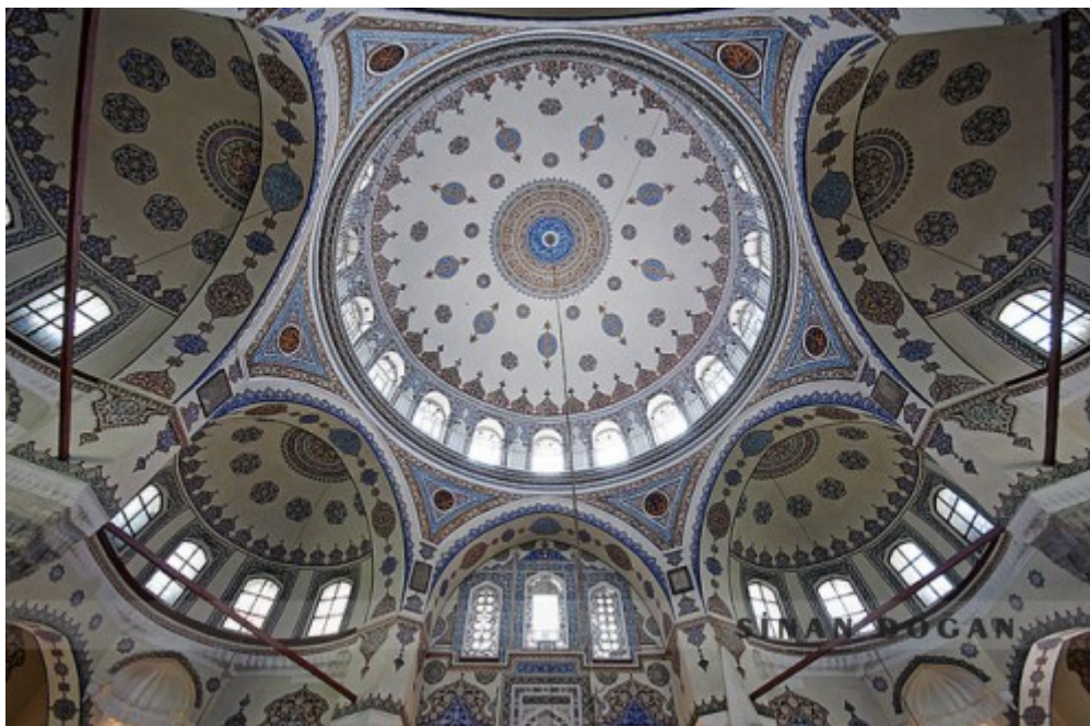
Obr. 33 Kopule v mešitě Kara Ahmeda Paši. Ukázka hexagonální podstavy kopule
