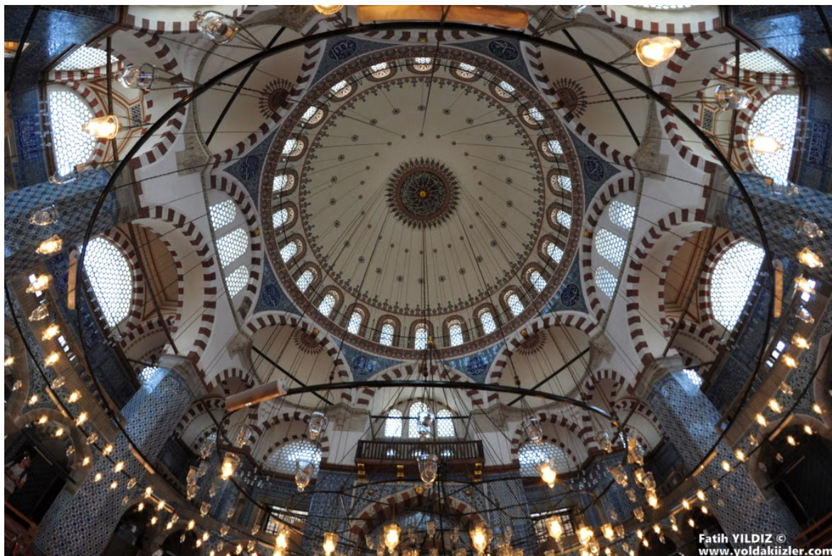
Obr. 37 Pohled na kopuli Rustema Paši. Ukázka oktagonální podstavy kupole
