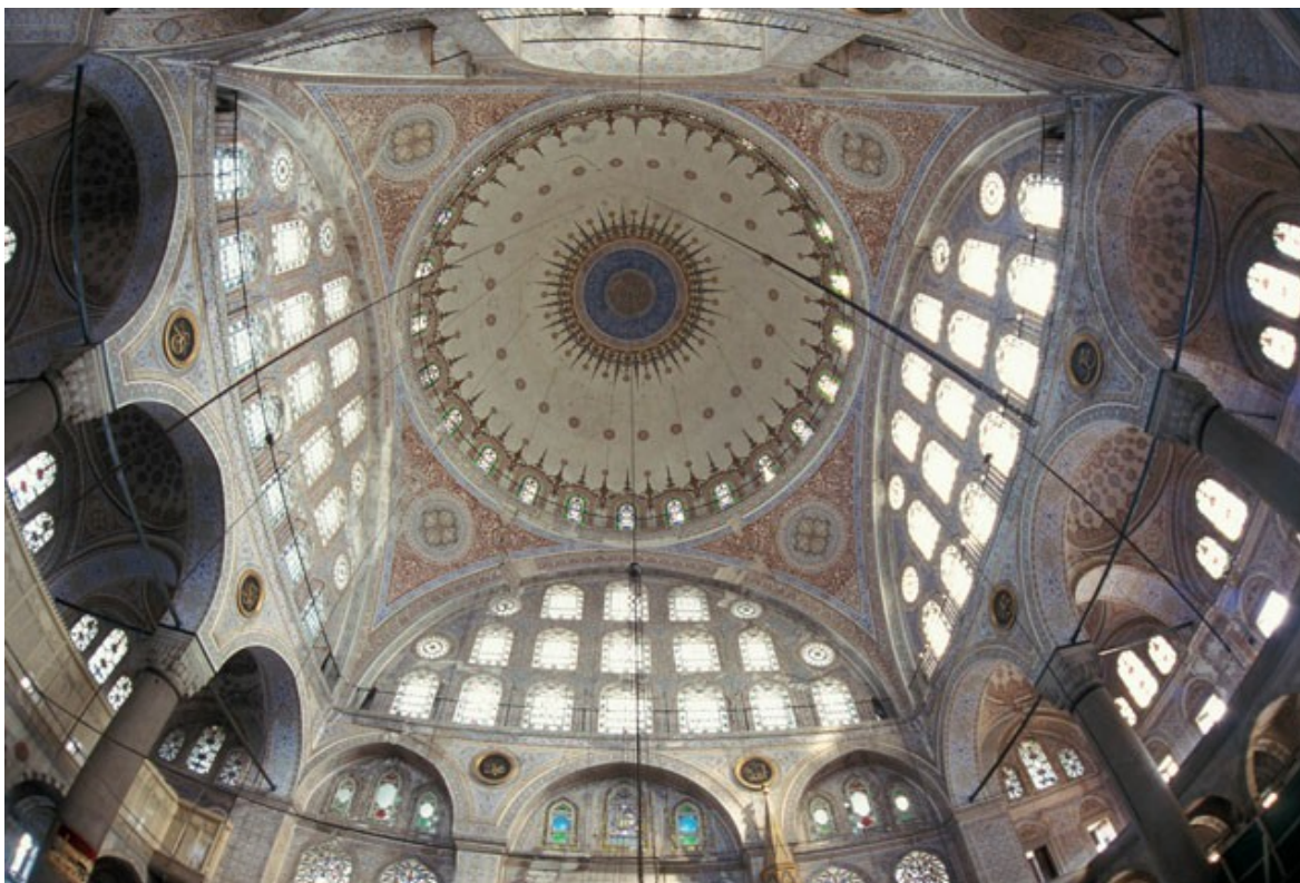
Obr. 23 Pohled na kupoli mešity Mihrimah Sultan v Edirnekapi. Kupole není nesena polokopulemi, pouze pendetivy.
