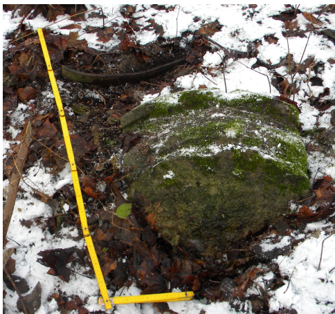
6 – nárožní část profilované římsy
