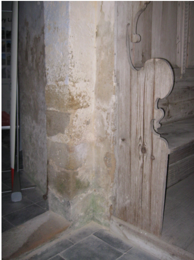
Foto 1 – Křivce – druhotně užitý prvky v ostění vstupního otvoru z presbyteria do sakristie
