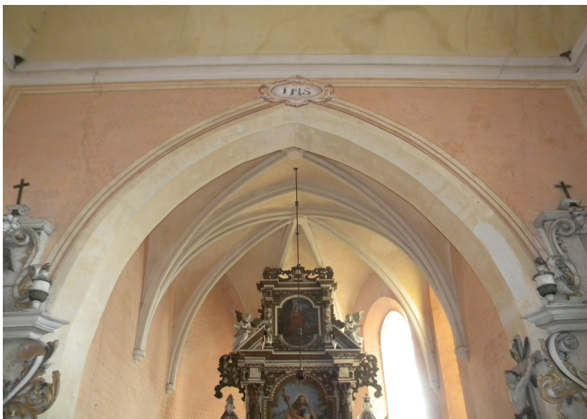
Foto 1 klenba nad presbyteriem (Vidžín)
