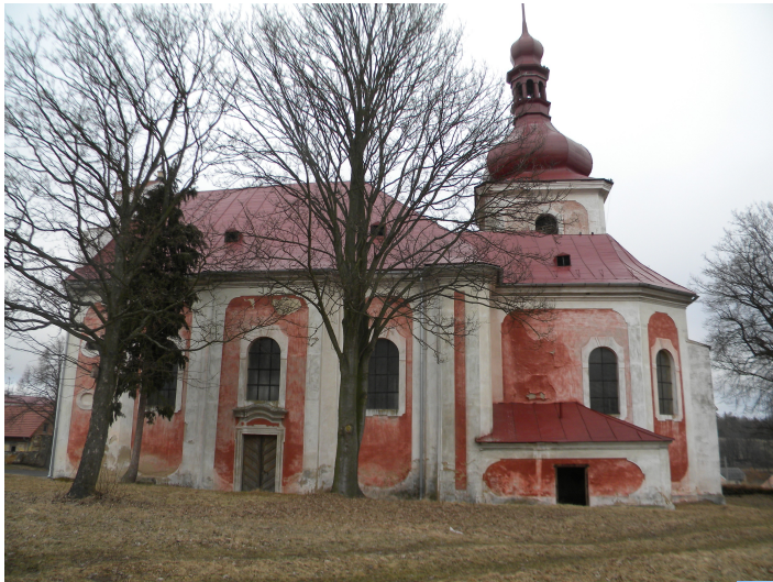
Úněšov – kostel sv. Prokopa
