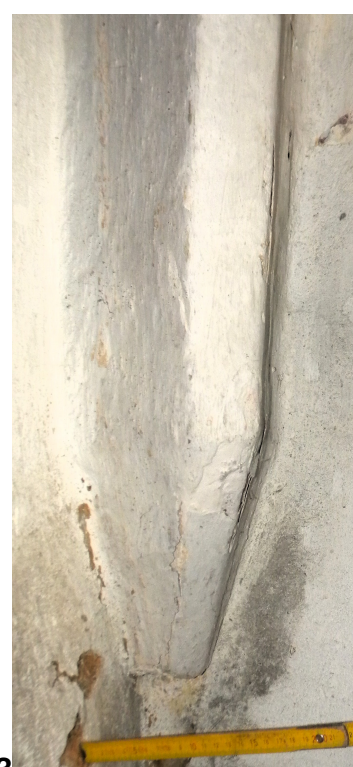
Pernarec – č. 1, č. 2 – konzoly žebné klenby nad presbyteriem, č. 3 – konzola žebné klenby nad sakristií
