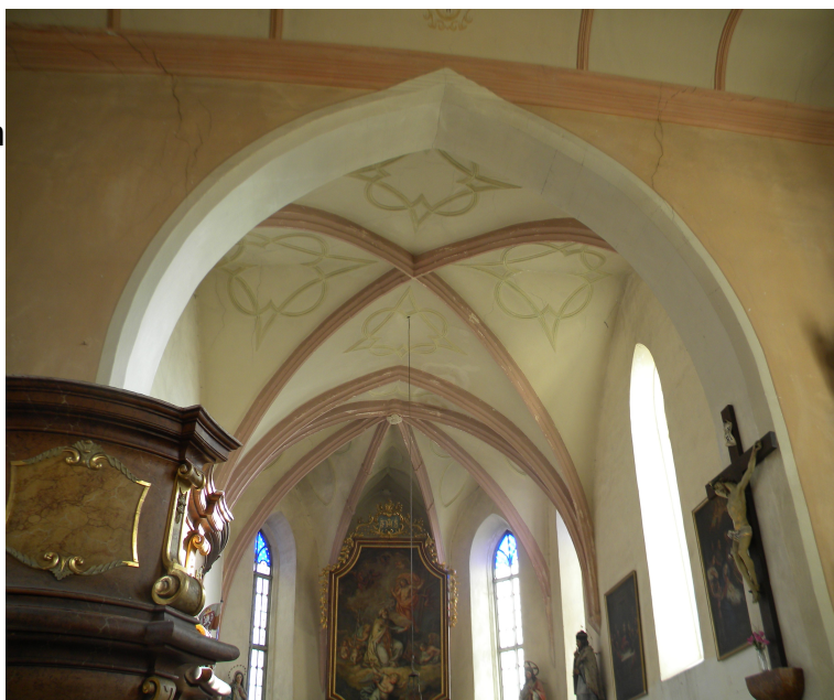
Foto 2 klenba nad presbyteriem (Pernarec)
