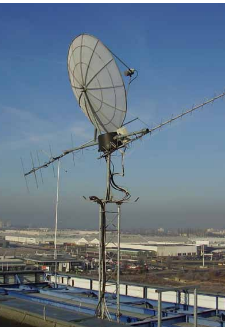
Pozemní stanice PilsenCUBE slouží k povelování a přijímání signálů malých družic.
