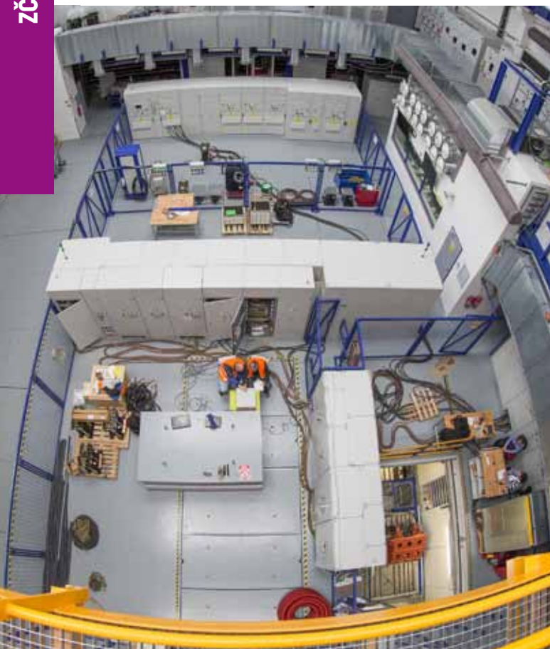
Halová laboratoř a zkušebna vysokonapěťové výkonové elektroniky a dopravní techniky.
