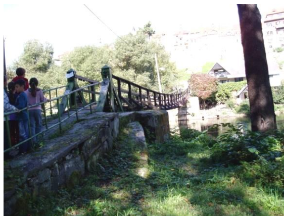
Houpací most přes řeku Ohři.
