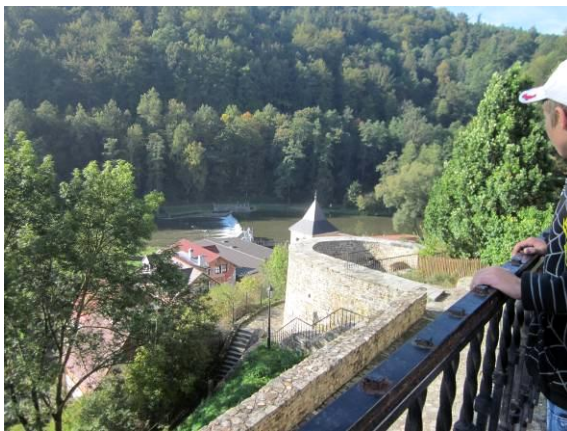
Výhled z parkoviště na hradby a jez na Ohři.
