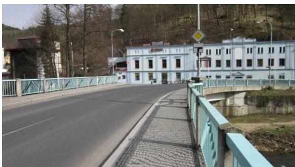
Silniční most, Epiag (bývalá porcelánka).
