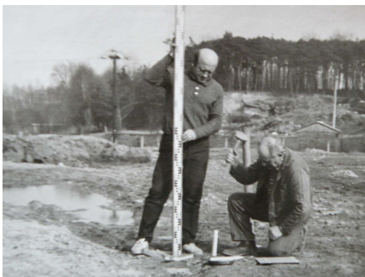
Obrázek č. 3 A. Havlovič a V. Cipra st. při práci na stadionu
