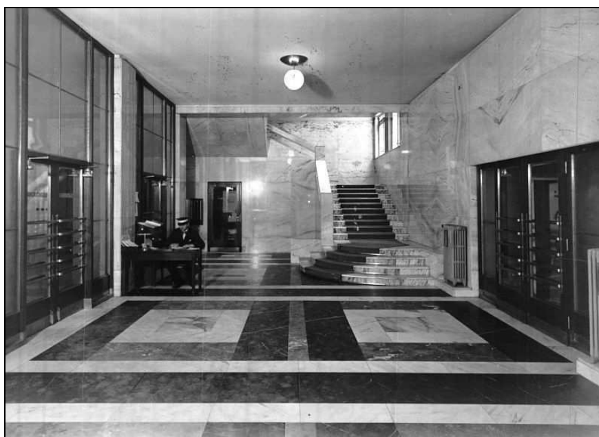
Obr. č. 12: Vstupní hala rozhlasu na Vinohradech v roce 1934 315
