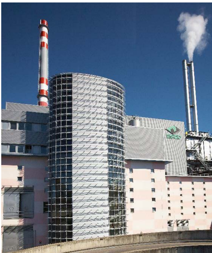
Obr. 14. Budova pračky spalin [6]
