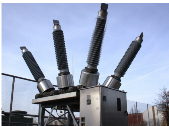
(b) Typ dead tank, Siemens 3AP2 DT 550 kV [23]
