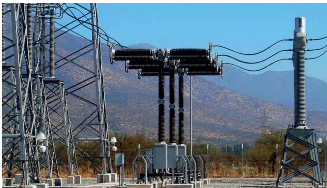
(a) Typ live tank, Siemens 3AP2 FI 420 kV [23]
