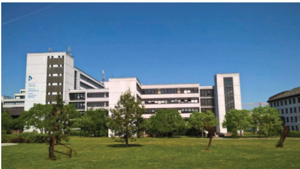
Obrázek 2-1: Budova fakulty strojní
